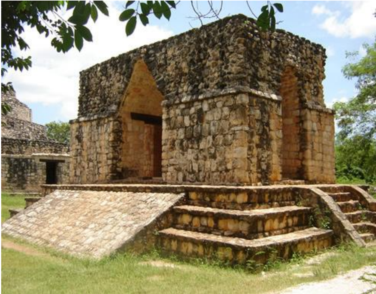
BÓVEDA EN SALEDIZO DE DOBLE CRUCERO, UBICADA SOBRE EL SACBÉ 2. FOTO DE LA AUTORA, 2010
