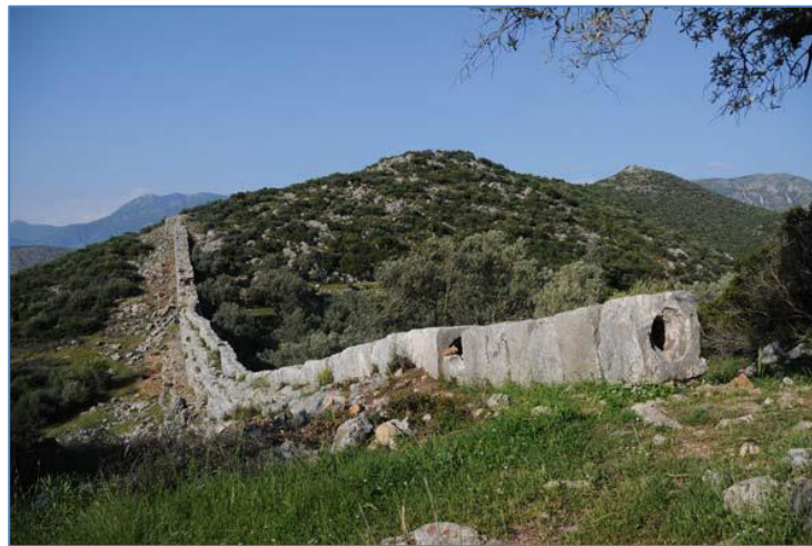
Figura II-8. Sifón invertido en Petara (Mays 2010)
