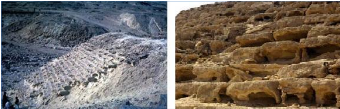
Figura II-3. Sadd el Kafara (2770 AC). Presa de los paganos en Egipto, vista de la presa mostrando el revestimiento del vaso (Mays 2010)
