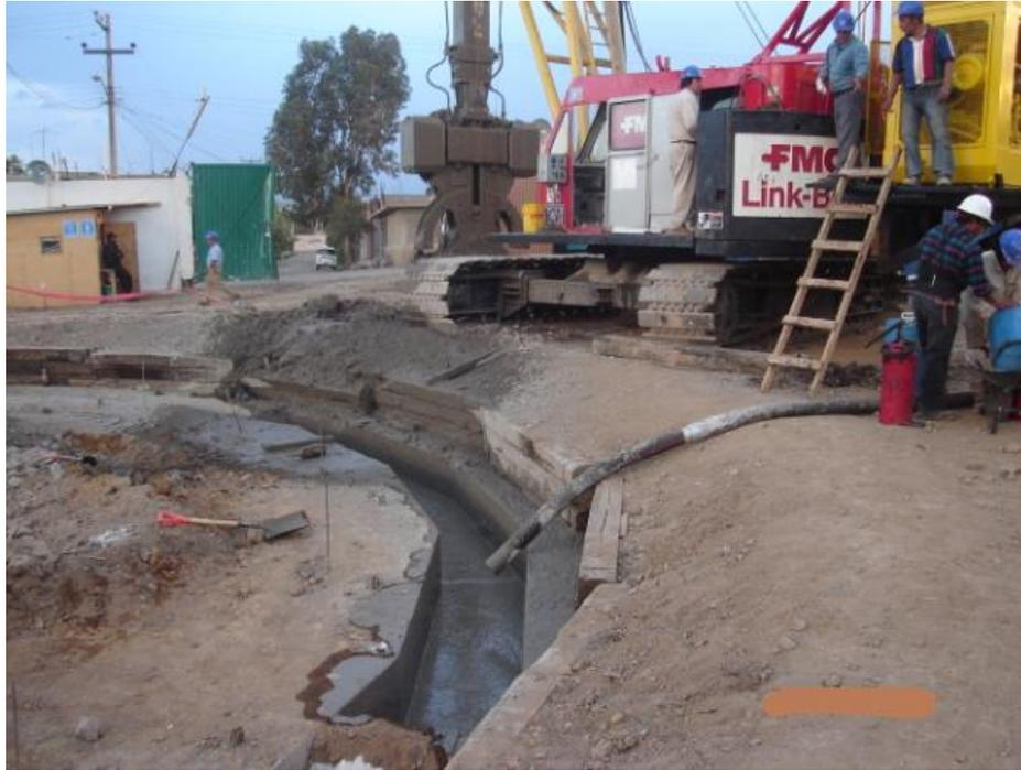
Figura (50) colocación de lodos bentoníticos para estabilizar el terreno
