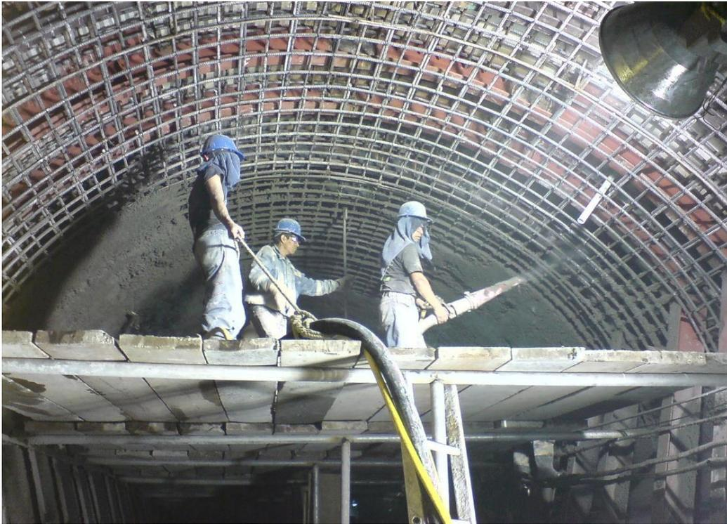
Figura (89) concreto lanzado
