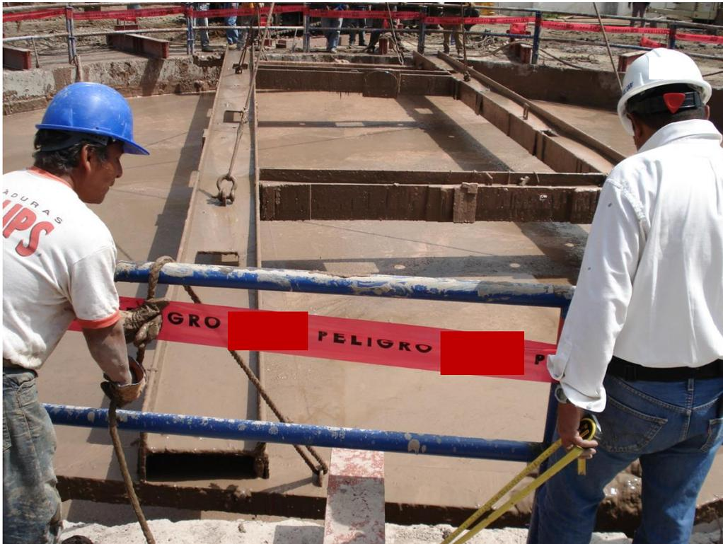
Figura (54) verificación del diámetro excavado
