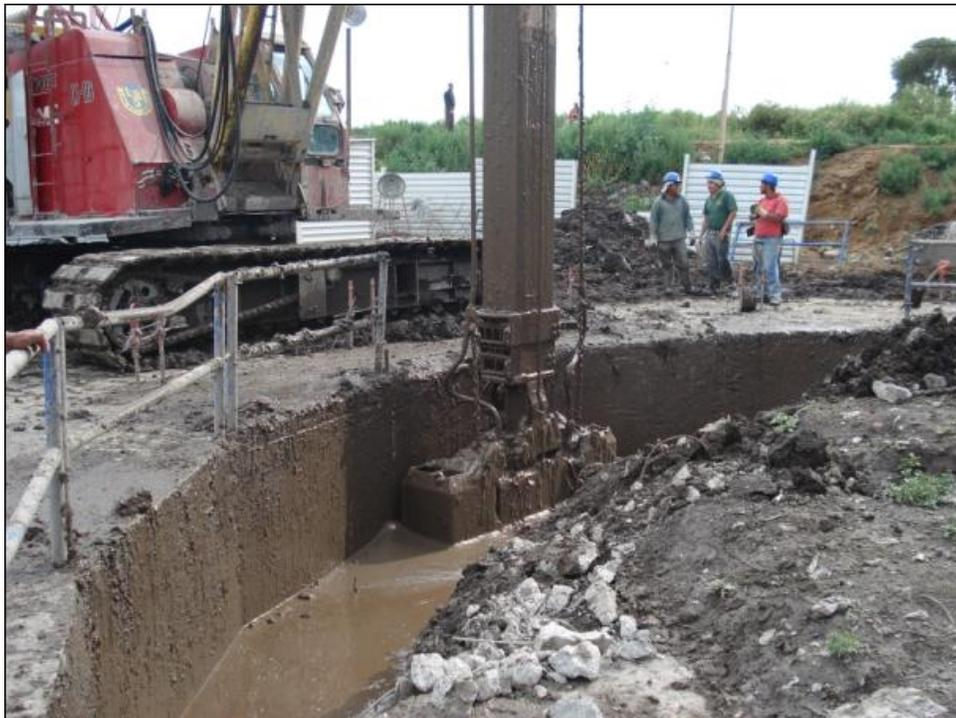
Figura (51) excavación de la zanja perimetral
