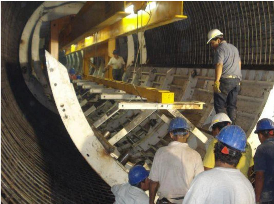
Figura (88) colocación de cimbra telescópica
