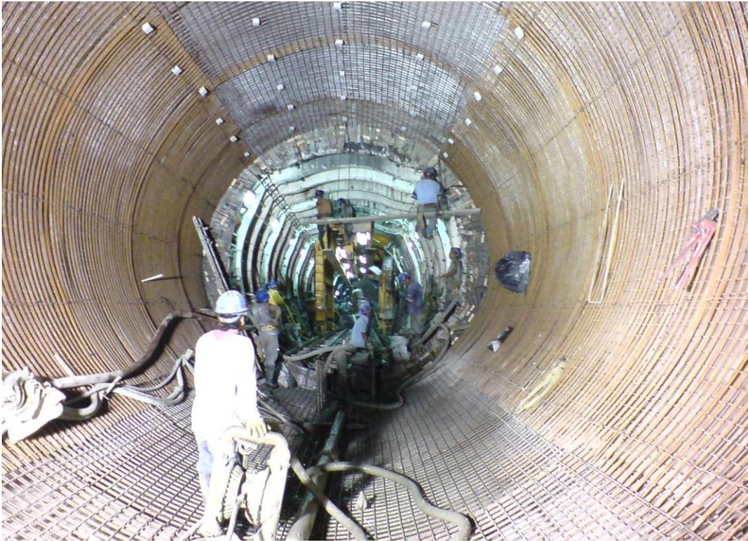
Figura (87) colocación de malla ingenieril
