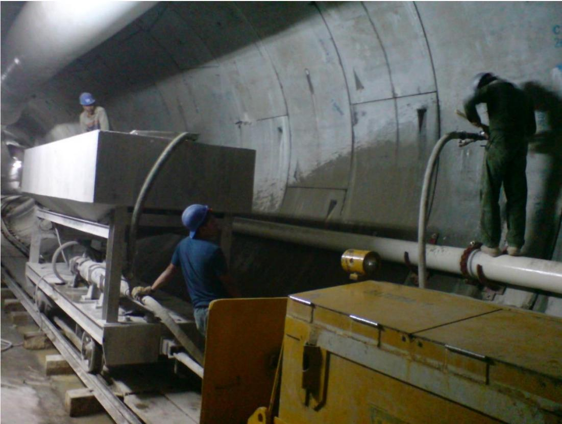
**Figura (82) relleno de espacio anular entre dovela y terreno**
