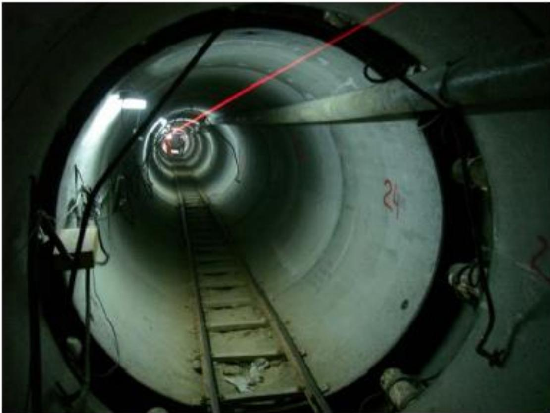
Figura (31) laser del túnel
