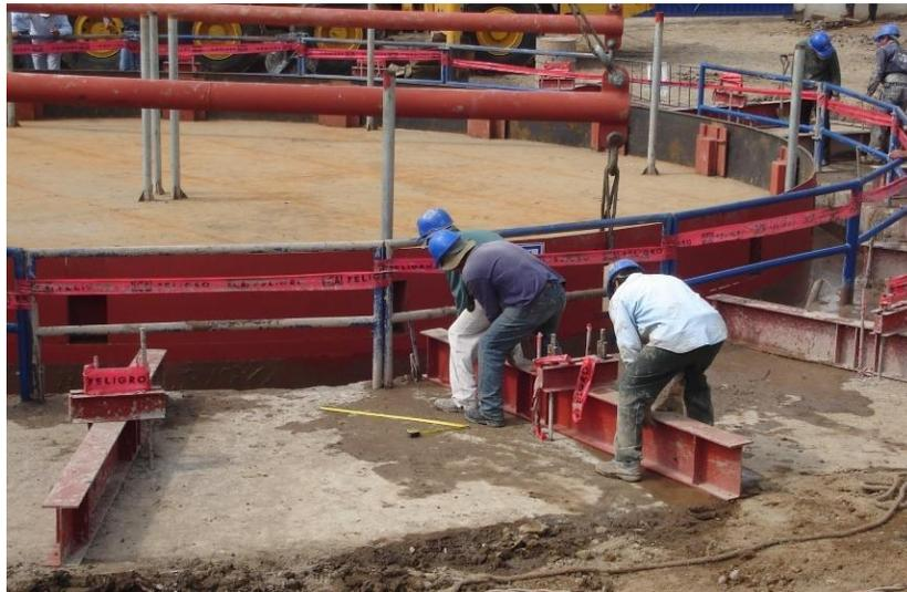
Figura (56) de instalación de vigetas de sujeción
