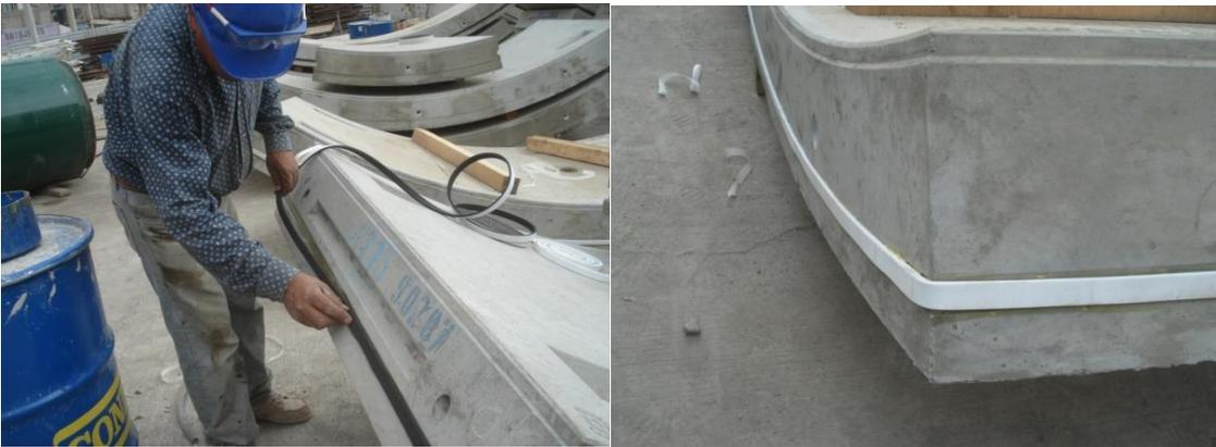
Figura (77) sistema de impermeabilización por medio de la colocación de un sello
