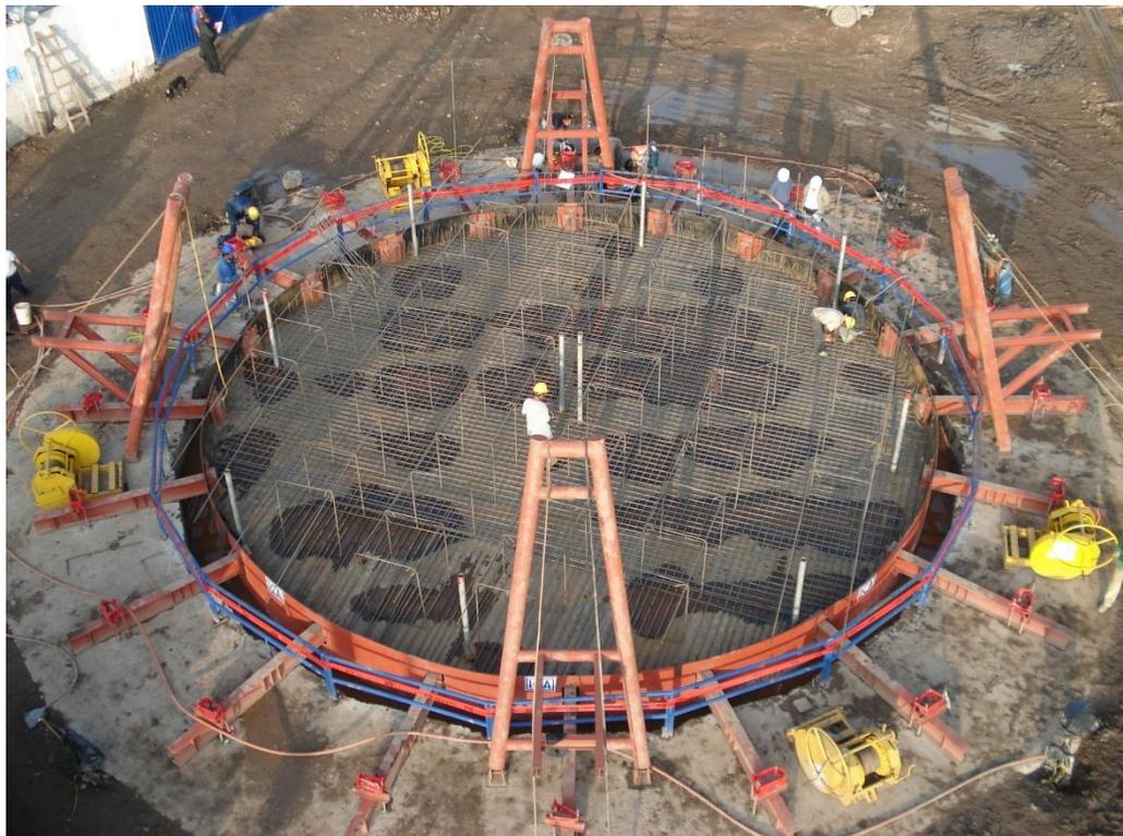
Figura (59) armado de la losa de fondo
