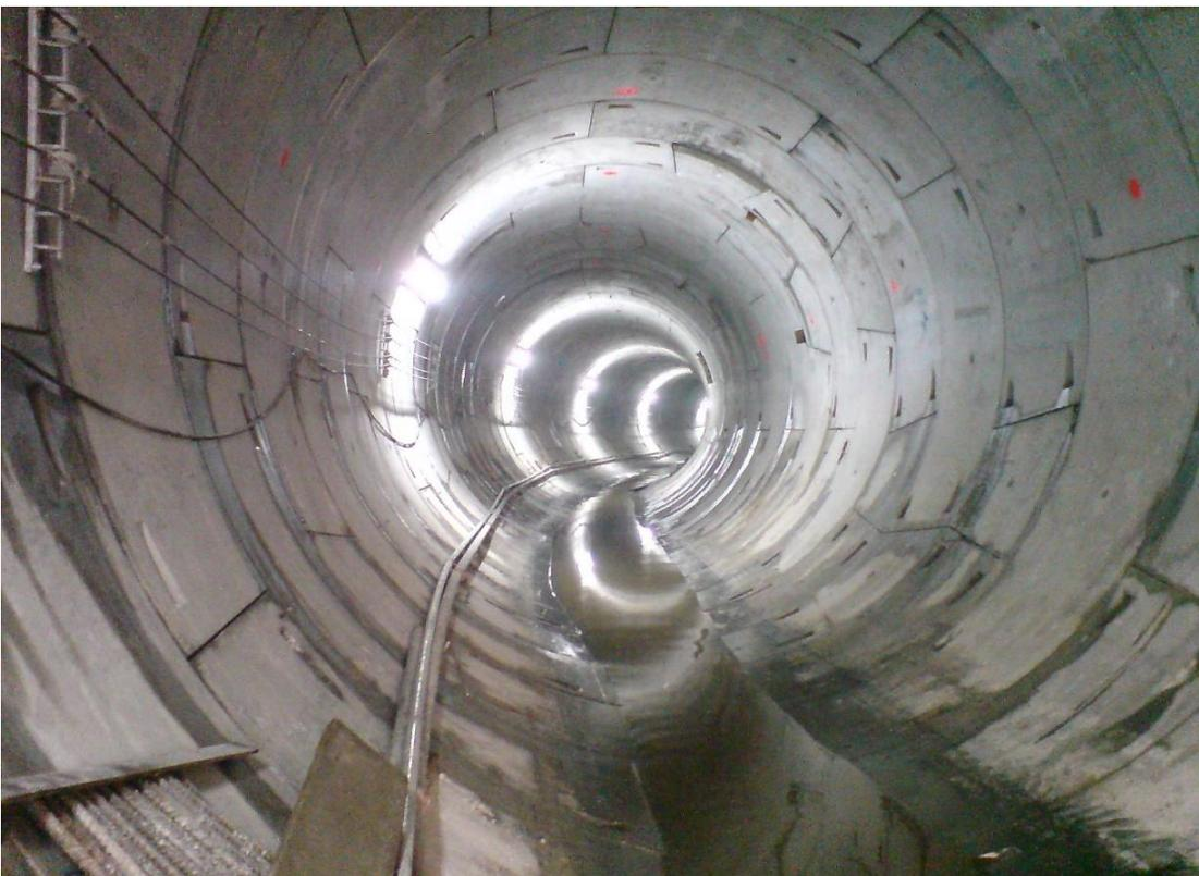
**Figura (83) revestimiento primario del túnel, mediante dovelas**
