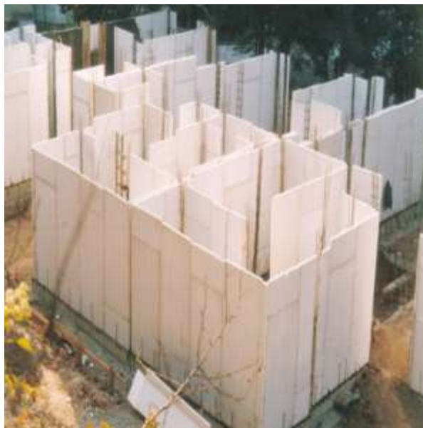
Fig. 1.2 Muros para casa habitación.
