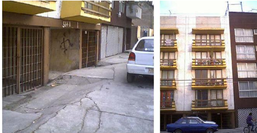
Foto 9 y 10 Falla en el estado de servicio de un edificio en ciudad de México
