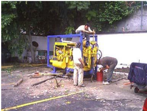
Fotos 1 a 4 Sondeos de exploración realizados en el predio
