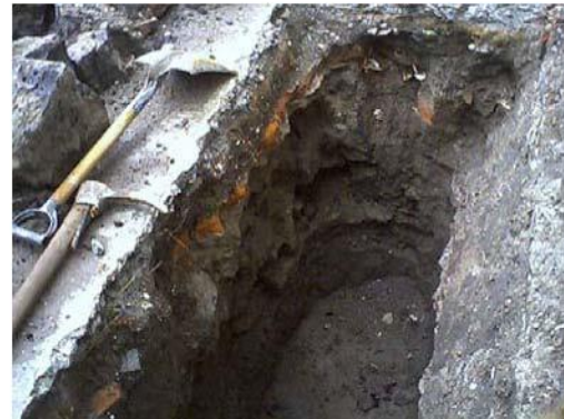
Fotos 1 a 4 Sondeos de exploración realizados en el predio
