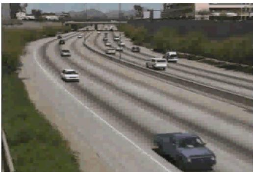
Representa circulación a flujo libre, hay libertad para conducir con la velocidad deseada y la facilidad de maniobrar dentro de la corriente vehicular es alta (no existen efectos por la presencia de otros usuarios). Nivel de comodidad y conveniencia del usuario es alta.
