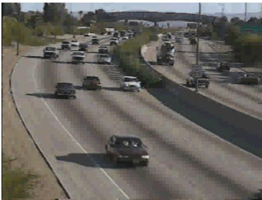
Aún en el rango de flujo estable, aunque empiezan a presentarse restricciones de geometría y pendiente y se siente de manera significativa la interacción con los otros usuarios. El nivel general de libertad y comodidad del conductor es adecuado aunque algo limitado.
