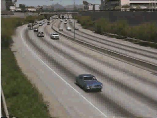
Dentro del rango de flujo estable, tiene restricciones al flujo libre o las especificaciones geométricas reducen la velocidad. Se disminuyen la libertad de conducir a la velocidad deseada y la facilidad de maniobrar. En general el nivel de libertad y comodidad que tiene el conductor es bueno, aunque empieza a sentirse la presencia de otros usuarios.
