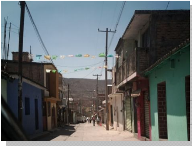
Imagen No. 19. Red eléctrica.
