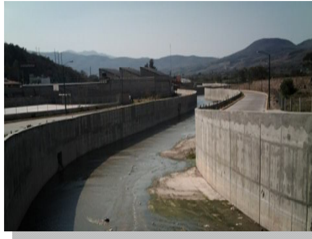
Imagen No. 5. Fotografía del Río Huacapa.
