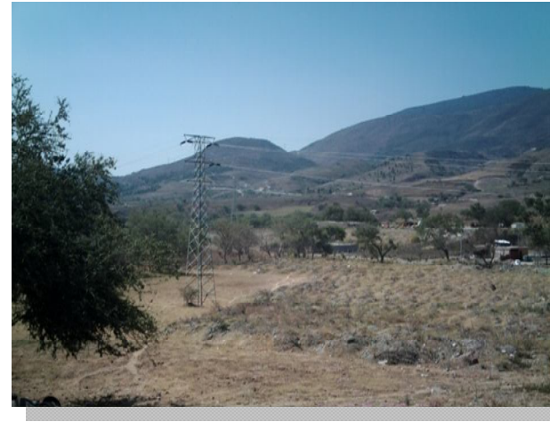
Imagen No. 20. Líneas de alta tensión.
