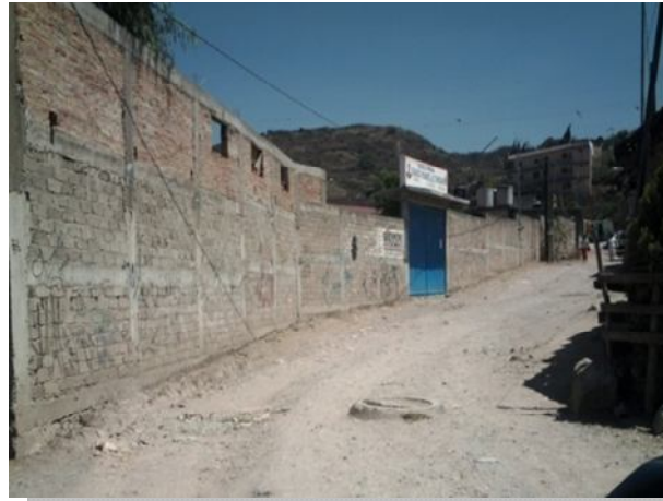
Imagen No. 17. Alcantarillado en la comunidad de Petaquillas.
