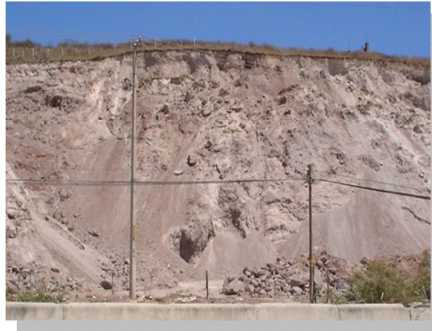
Imagen No. 6. Corte de terreno.
