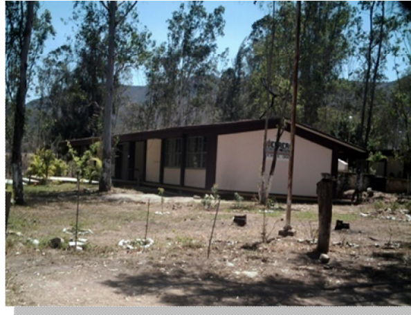
Imagen No. 27. Escuela Secundaria en la zona sur.
