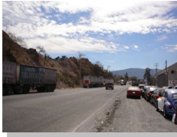
Imagen No. 12. Construcción del Boulevard Chilpancingo-Petaquillas (tramo de la carretera Chilpancingo-Acapulco).
