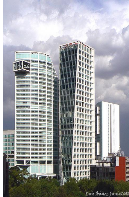
FACHADA DE REFORMA 222
