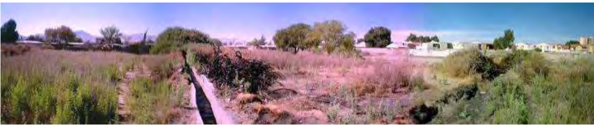
Imagen N°3 Canales de Regadío
