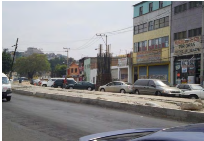
Figura 4.6 Queda evidenciada la reducción de carriles por los trabajos iniciados de construcción. Se aprecia una estructura de varilla justo en medio de lo que era un carril. Fuente: fotografía de autoría propia.
