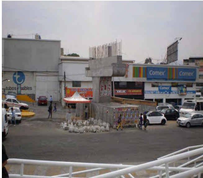
Figura 4.5 Estado actual de la obra. El que sería uno de los soportes del distribuidor vial. Vemos cómo es utilizado para pegar publicidad. Fuente: fotografía de autoría propia.
