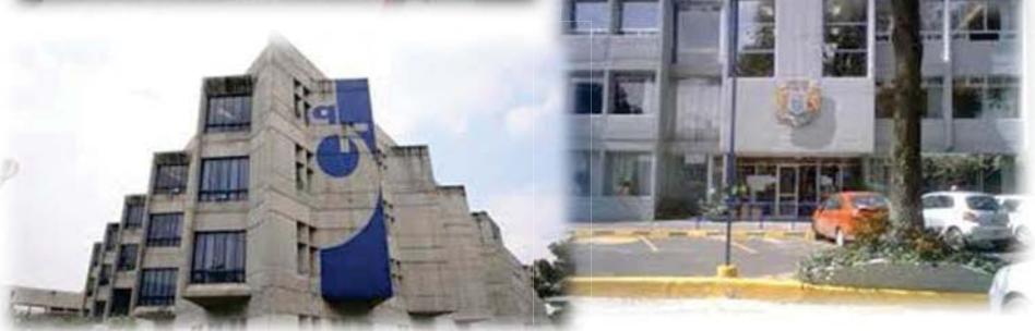
Fig. 34 Algunos equipamientos destacados
