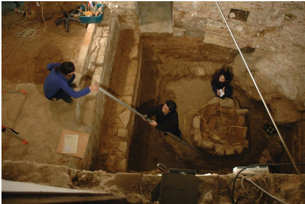
Fig. 21 Rehabilitación de estructura Ca la Dona
