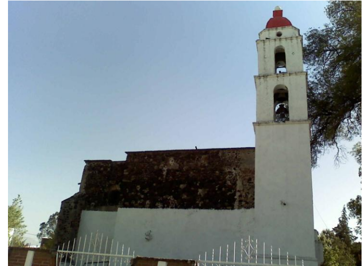
V6.- Vista lateral de la capilla
