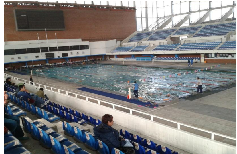
Vista de la alberca olímpica desde gradería
