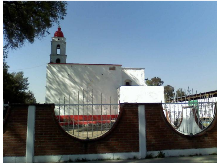
V11.- Vista lateral de la capilla
