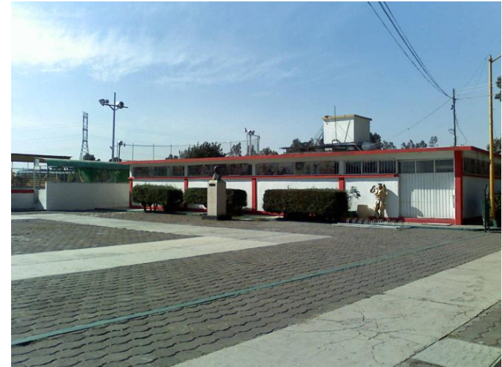
V8.- Vista al gimnasio de la unidad deportiva
