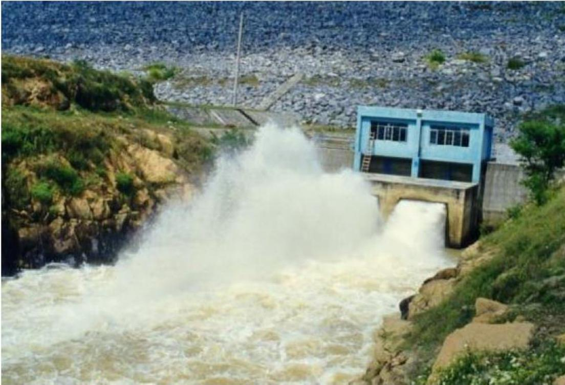
Figura. 3.2.9.1. Vertedor Auxiliar Funcionando Cuando las Avenidas son Rebasadas.
