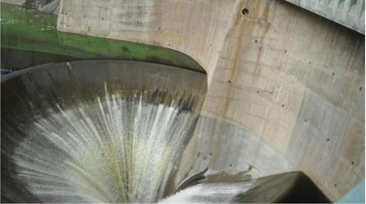
Figura. 3.2.3.3. Vertedor en Embudo.
