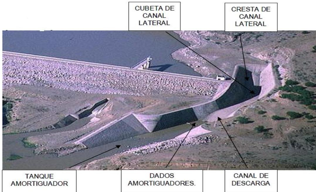
Figura 3.2.8.1. Elementos que constituyen un Vertedor de Canal Lateral.
