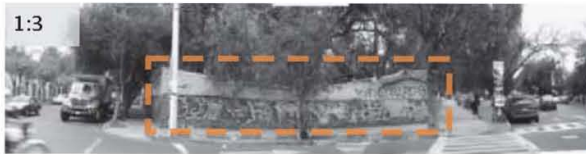
Fachada Norte - Paris
