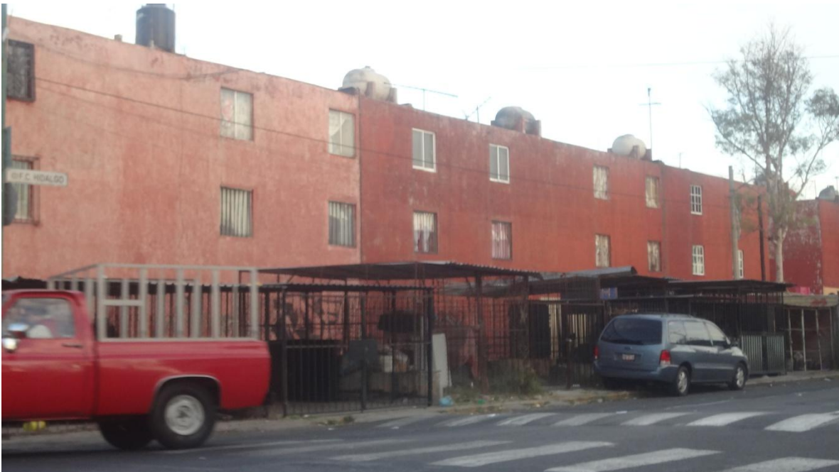
La falta de observancia a la ley y el poco respeto por sus vecinos ha desvirtuado cualquier buena intención del gobierno capitalino por dotar de una vivienda digna a sus habitantes.
