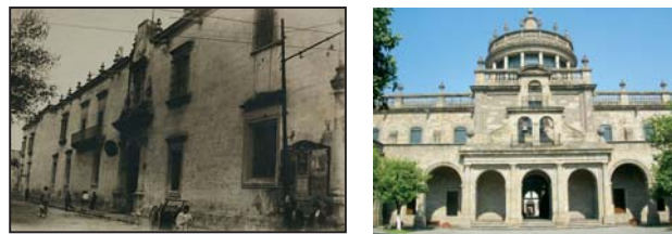
Figuras 4 y 5. A la izquierda el antiguo edificio del Seminario Conciliar de San José que funcionara como sede del Liceo de Varones entre 1861 y 1914. Hoy Museo Regional de Guadalajara. Archivo fotográfico MRG. A la derecha. Fachada del Hospicio Cabañas. Reprografías.
