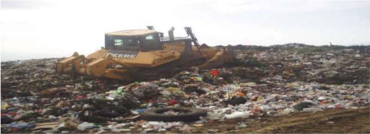
Compactación de residuos
