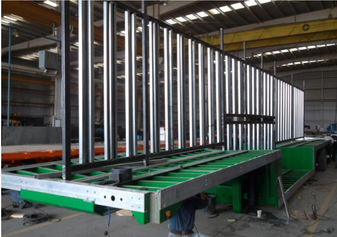
Figura 3.53. Seguimiento en fabricación de unidad prototipo (fase 3). Plataforma Kola Real.
