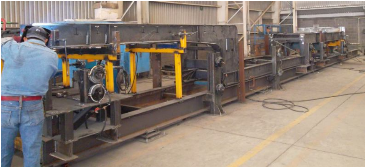
Figura 3.51. Seguimiento en fabricación de unidad prototipo (fase 1). Plataforma Kola Real.
