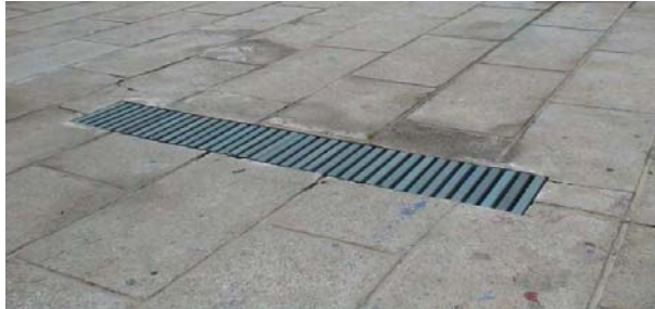
Rejilla/coladera en orilla de naves industriales
