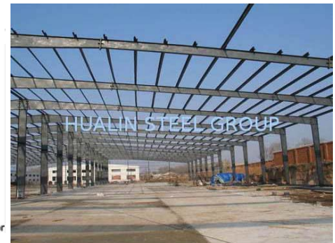
Sistema de armaduras en grandes claros y largueros sobre estas.
