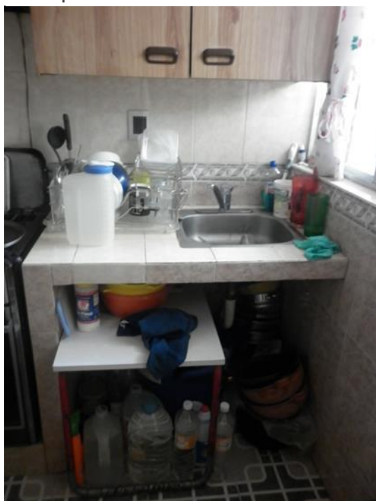
Ilustración 6 Adecuaciones en cocina. Mesa de trabajo baja y espacio libre de puertas.
