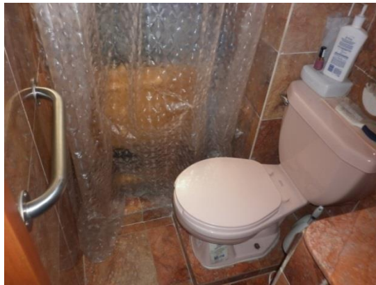
Ilustración 5 Adecuaciones en el baño. Barra de apoyo y escalón para el W.C.
