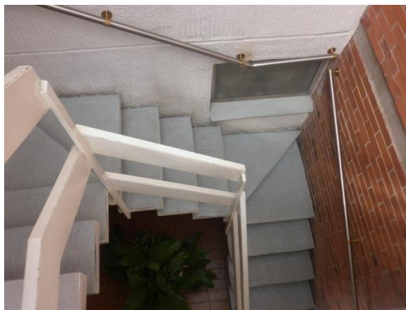
Ilustración 2 Escalera de acceso al interior de la vivienda, con barra de apoyo.
