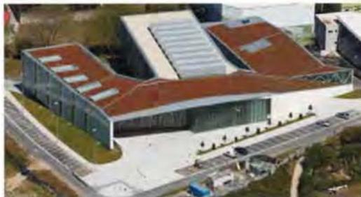
El conjunto muestra un volumen continuo en su acceso y seccionado hacia la zona posterior, con patios que quedan entre los elementos principales que conforman un exterior amable. Los edificios están diseñados en forma de caja, con una estructura de celosías metálicas, fachadas acristaladas y cubiertas ecológicas.
