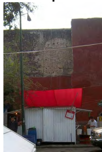
c) Arco cegado en P.A.
