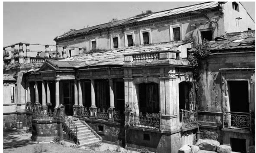
Imagen 77. Estado actual del edificio. Actualmente existe un proyecto de remodelación y hacer de él un centro cultural.
