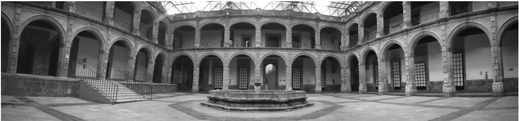
Imagen 57. Estado actual del interior del ex Hospital. Debido a su uso actual luce sin actividad la mayor parte del tiempo. Posee una cubierta a base de armaduras metálicas y policarbonato.
