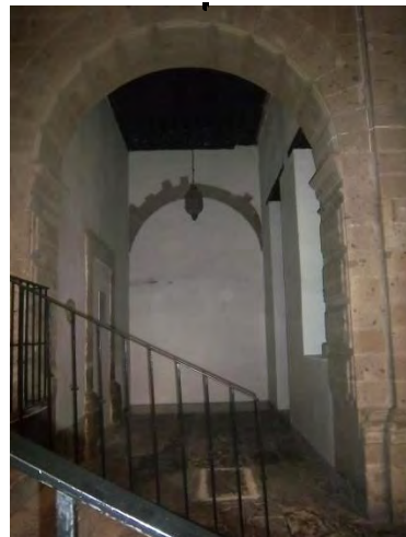
b) Arco cegado en P.B.
