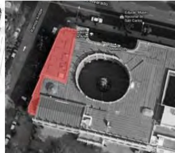
Imagen 12. Vista aérea del edificio. Aparece en rojo la ampliación.
