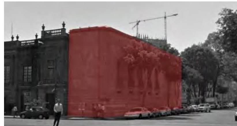
Imagen 13. Estado actual del edificio, se advierte la integración al antiguo edificio.
