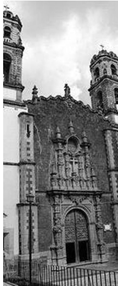
Imagen 64. Fachada principal del templo, desde el acceso del Museo de la Estampa.
