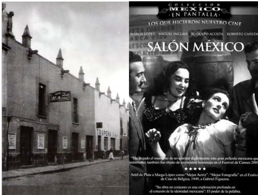
Imagen 76. El salón en la década de los años treinta, siendo demolido en los años sesenta.
