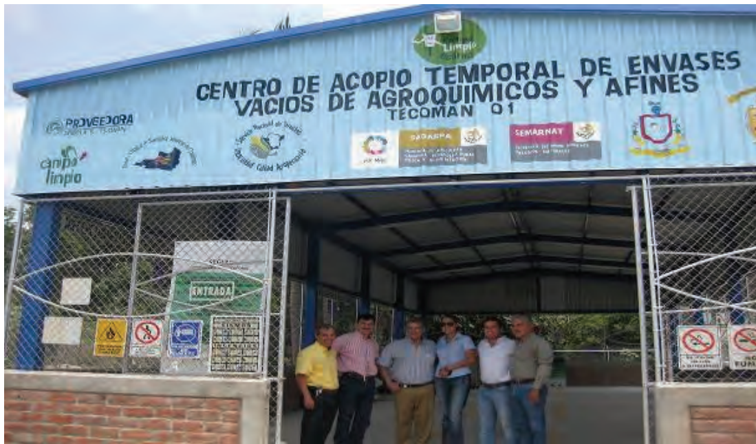
Figura 20. Centro de acopio temporal (135, 139,140).
