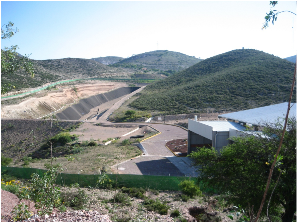
Confinamiento de residuos tóxicos y peligrosos
