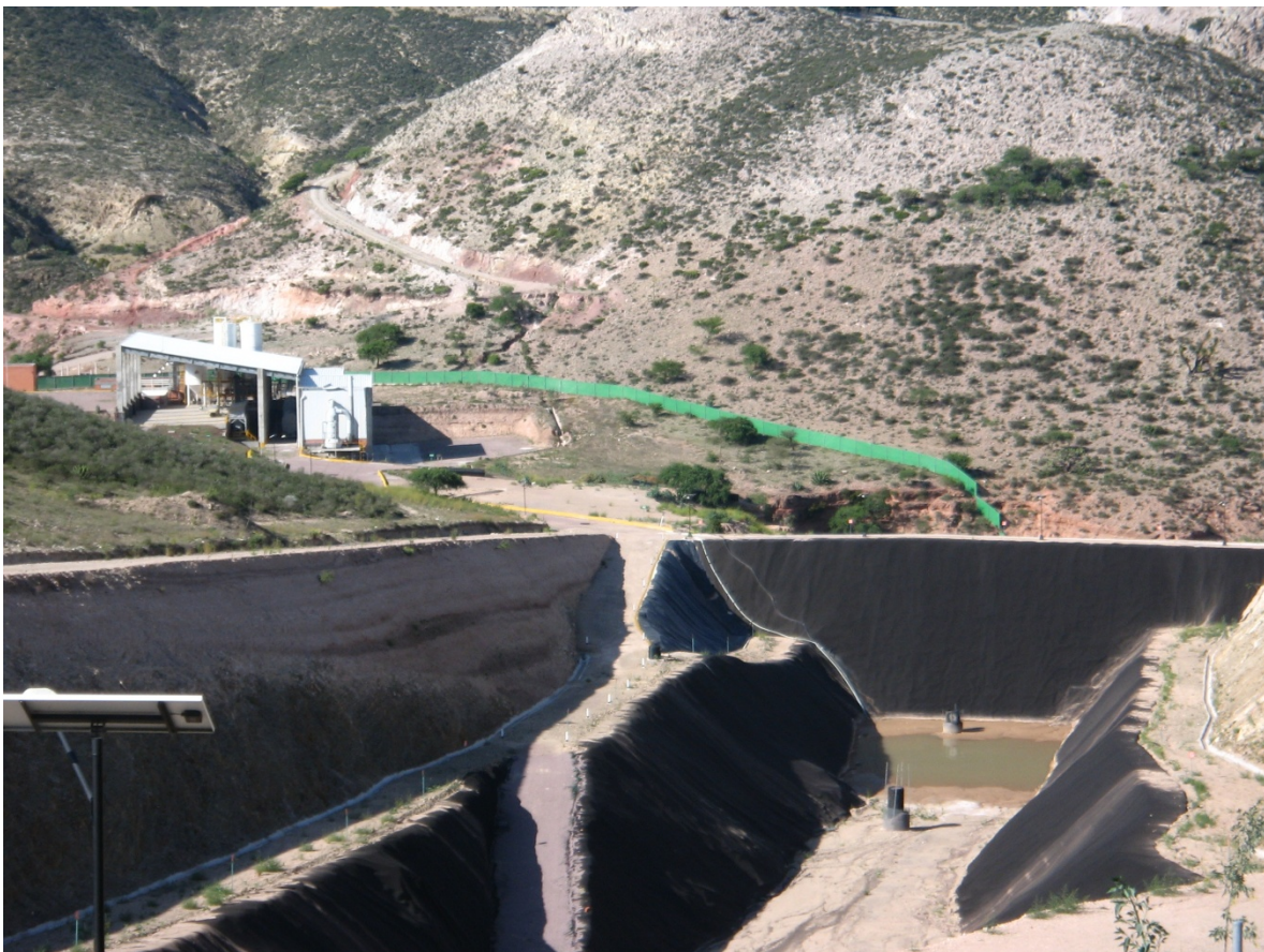
Hueco en donde se depositarían los residuos tóxicos. Foto: Edith Molina.
