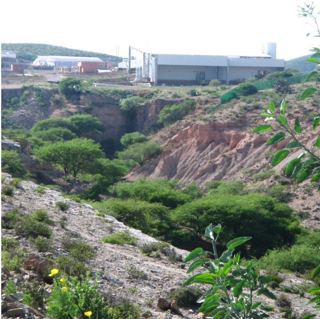
Instalaciones del confinamiento de Befesa
