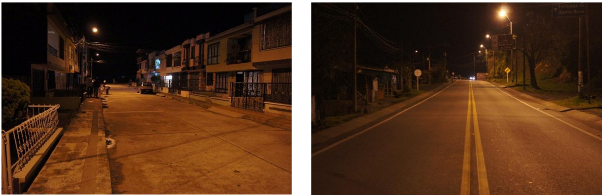
Figura 1.17 Vialidades iluminadas con sistemas de VSAP
