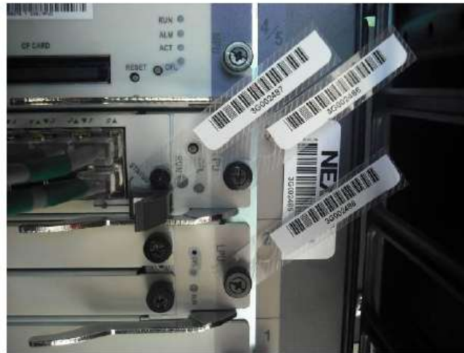
Figura 2.30.- Muestra de etiqueta activo fijo, Instalación de Etiquetas en Sitio.
