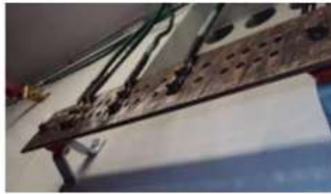
Figura 2.7.- Barra de tierra de rack 19" Figura 2.8.- Barra de tierra de rack 19" y barra 3G.
