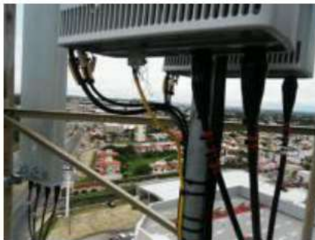
Figura 2.46.- Trayectoria cableado mástil soporte.
