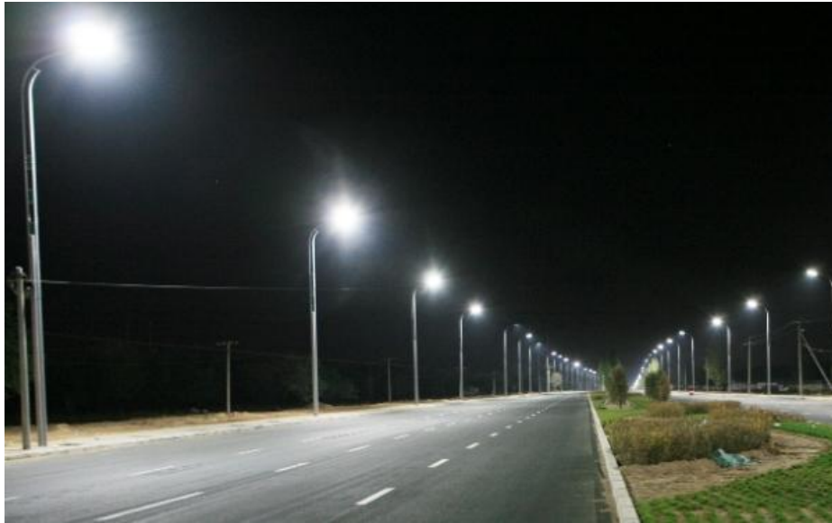
FIGURA V.5: Alumbrado público con lámparas de inducción en el país de Canadá, donde se puede observar que existe un alto índice de rendimiento de color.
