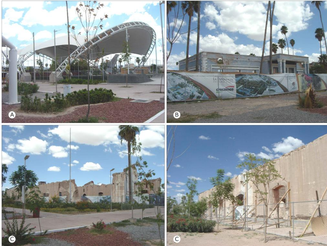
Ilustración 37. Jabonera La Esperanza. (A) integración de cubiertas para cubrir las canchas deportivas. (B) oficinas administrativas. (C) área de producción, sus muros son de adobe entre 80 cm de espesor, mientras que sus vanos son enmarcadas con tabique; según las perspectivas del proyecto nuevamente se cubrirán estos espacios con una estructura metálica exenta del edificio. Colección particular, año 2013.
