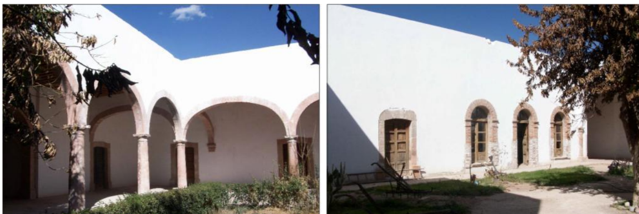
Ilustración 25. Izquierda: detalle de la arcada elíptica del segundo patio, construido a finales del siglo XIX. Derecha: comedor con jambas y arco de medio punto de tabique en vanos. Colección particular, año 2011.
