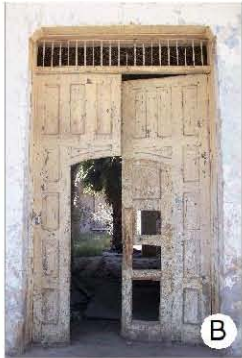
DETALLE DEL ACCESO PRINCIPAL
