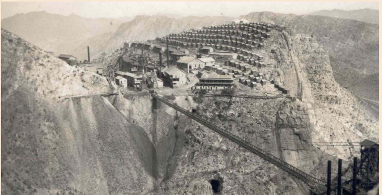
Ilustración 30. Pueblo minero de Ojuela, cercano a la ciudad de Mapimí. En primer plano se aprecia el puente colgante (trescientos metros de longitud), el cual une al asentamiento con la mina; en la cima del cerro podemos ver las casas para los trabajadores, mientras que en la ladera de enfrente vivían los norteamericanos. Imagen obtenida en: http://foros.elsiglodetorreon.com.mx
