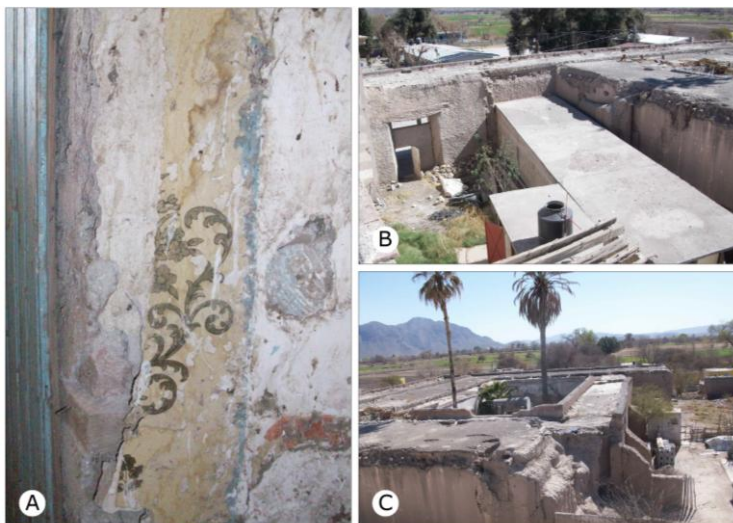
Ilustración 38. Hacienda La Goma. (A) fragmento de tapiz original en salón de recepciones. (B) adición de módulo de paredes de block y losa de concreto, en cuyo interior se aloja un museo. Acertadamente la nueva construcción no tocó la finca. (C) al colapsar el comedor, se le adicionaron unos contrafuertes de adobe para evitar el derrumbe del patio interior. Colección particular, año 2011.
