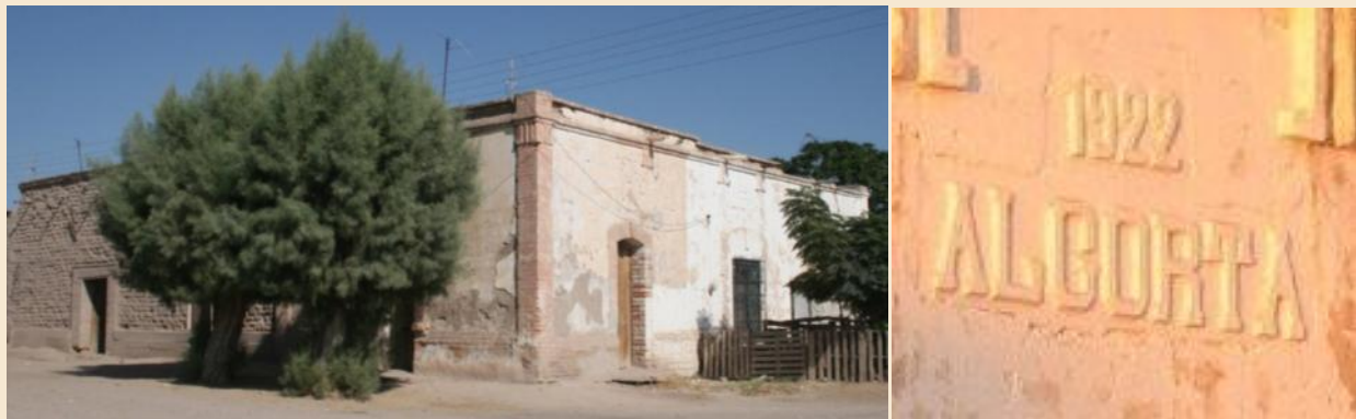
Ilustración 31. Hacienda Algorta (1922) ejemplo de las haciendas post-revolucionarias en La Laguna. En su fábrica se observa el empleo de muros de adobe y la presencia del tabique en sus vanos, cornisa y aristas de la construcción. Fotografía tomada de: www.panoramio.com/photo/5295389 y 5457262
