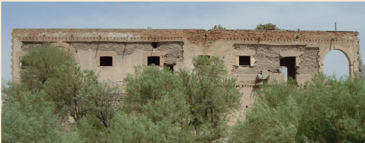
Ilustración 39. Hacienda de Hornos. Superior: se aprecia el colapso de la crujía sur y la esquina sureste; actualmente lo ocupan dos construcciones de adobe de un solo nivel que fueron añadidas. Las escaleras que comunicaban al segundo nivel han desaparecido, así como el deambulatorio de madera que comunicaba a los cuartos en la planta alta se encuentra en mal estado y es difícil su acceso. Inferior: la crujía poniente no ha sido intervenida, ha perdido parte de sus aplanados y presenta flora nociva en su cubierta. Detalle de la bodega en planta baja (A); de la hornilla en la cocina (B) y detalle de arco en terraza en planta alta (C). Colección particular año 2011.
