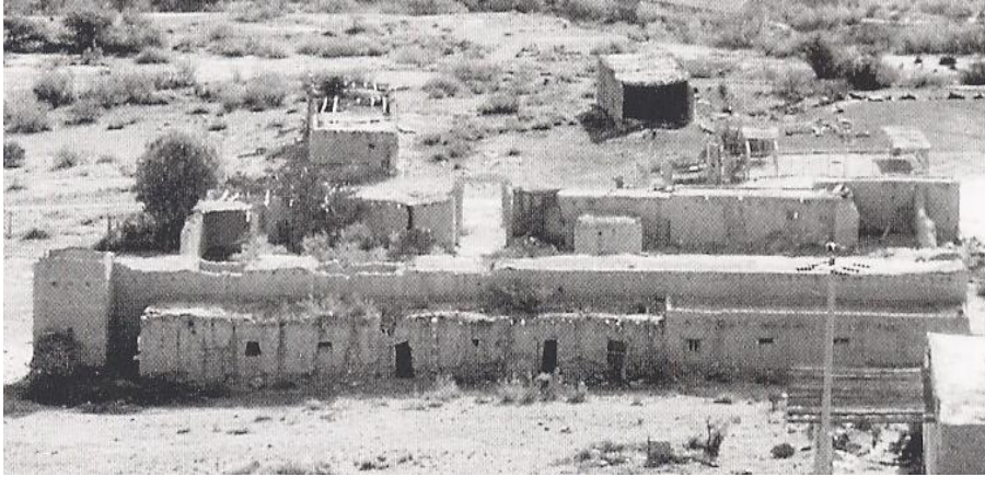
Ilustración 4. Casco de la ex hacienda de Santa Isabel en Parras Coahuila, ejemplo de fortificaciones en las primeras haciendas para la defensa de las incursiones de indios nómadas. Fotografía propiedad de Gildardo Contreras Palacios, tomado del libro: Torreón Ciudad Centenaria , p. 48
