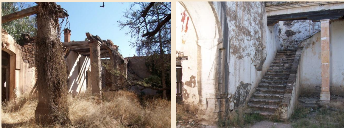
Ilustración 52. Interior de la hacienda de Santa Catalina en Durango. Izquierda, detalle del patio central, cuyo deambulatorio presenta columnas de cantera que sostienen gualdras de madera que reciben el envigado. Derecha: escalera de cantera que comunicaba a las habitaciones superiores del frente de la finca, cuyo sistema constructivo para el segundo nivel es semejante a la hacienda de Hornos. Colección particular, año 2012.
