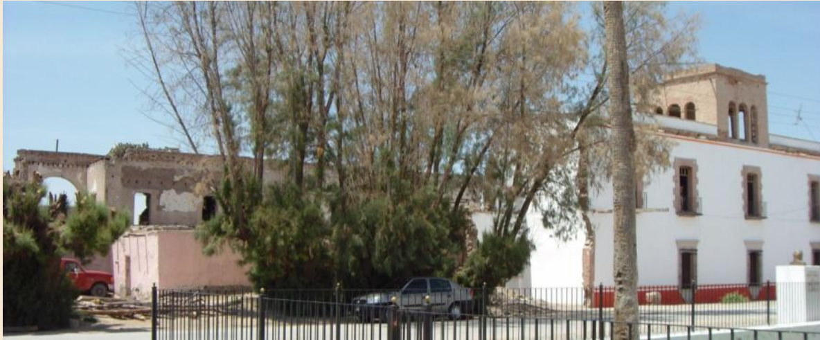
Ilustración 39. Hacienda de Hornos. Superior: se aprecia el colapso de la crujía sur y la esquina sureste; actualmente lo ocupan dos construcciones de adobe de un solo nivel que fueron añadidas. Las escaleras que comunicaban al segundo nivel han desaparecido, así como el deambulatorio de madera que comunicaba a los cuartos en la planta alta se encuentra en mal estado y es difícil su acceso. Inferior: la crujía poniente no ha sido intervenida, ha perdido parte de sus aplanados y presenta flora nociva en su cubierta. Detalle de la bodega en planta baja (A); de la hornilla en la cocina (B) y detalle de arco en terraza en planta alta (C). Colección particular año 2011.
