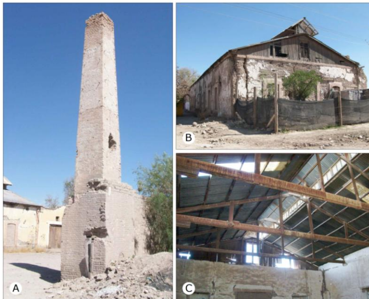
Ilustración 36. Hacienda El Pilar. (A) chacuaco de tabique, al fondo se aprecian una bodegas construidas en los años 30's. (B) galerón del despepite, sus muros son de adobe con un espesor de 80cms., los vanos de ventanas y accesos son de tabique. (C) interior del despepite, presenta una armadura de madera con cubierta de lámina, además de una abertura para la extracción del calor. Estos tipos de espacios están presente en la mayoría de los ejidos de la región. Colección particular, año 2011.
