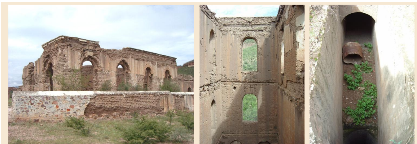
Ilustración 4. Vestigios del obraje de la hacienda de Belén, cercana a Peñón Blanco. Sus muros son de adobe con un espesor promedio de noventa centímetros, presenta vanos con arcos de medio punto y su sistema de cubierta, de entablado de madera, ha desaparecido. Utilizaba en su interior un sistema hidráulico como fuerza motriz. Colección particular, año 2013. Página siguiente: croquis de la derivación del afluente al inmueble.
