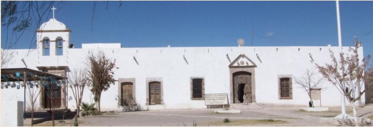
Ilustración 7. Elevación actual de la hacienda La Loma, cuya capilla familiar es una anexión posterior. Además se puede observar en su pretil el empleo de troneras o mirillas para la defensa del lugar. Colección particular, año 2011.
