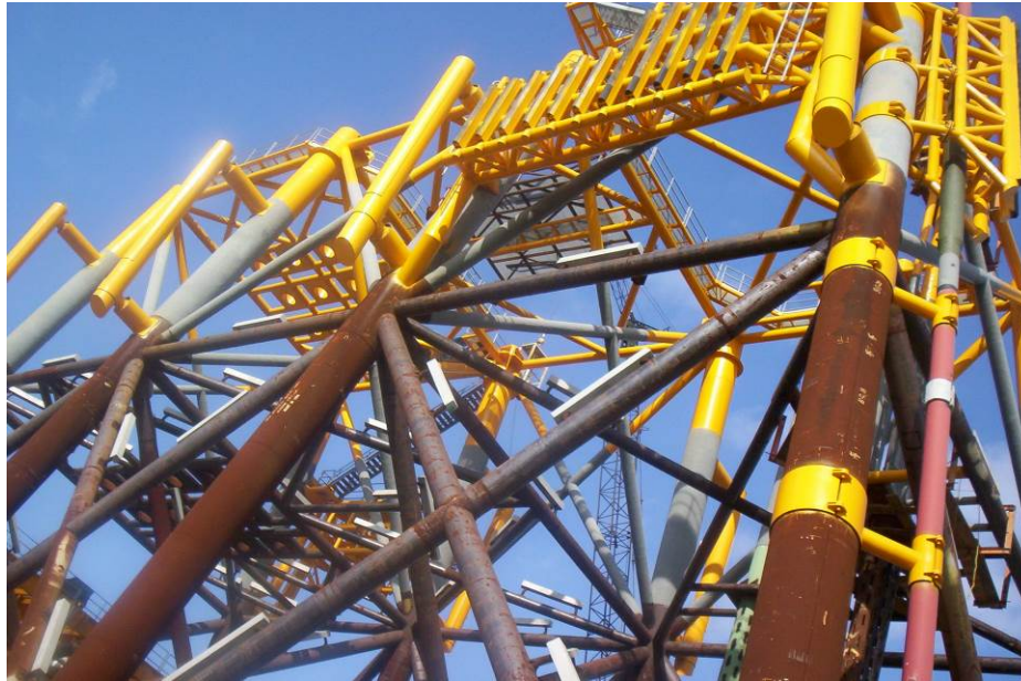
Figura 2.17. Accesorios de la subestructura.
