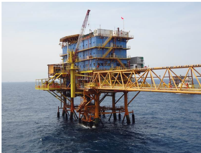
Figura 2.33. Plataforma Habitacional. (HA-Abkatún-A)
