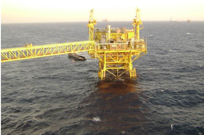
Figura 2.35. Plataforma de generación eléctrica (PG-Zaap-C).
