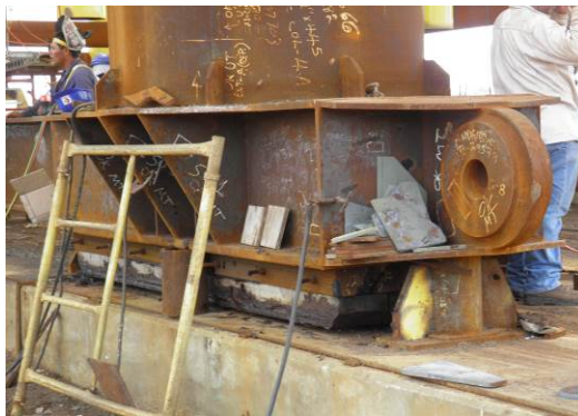
Figura 2.26. Oreja de arrastre de una superestructura.
