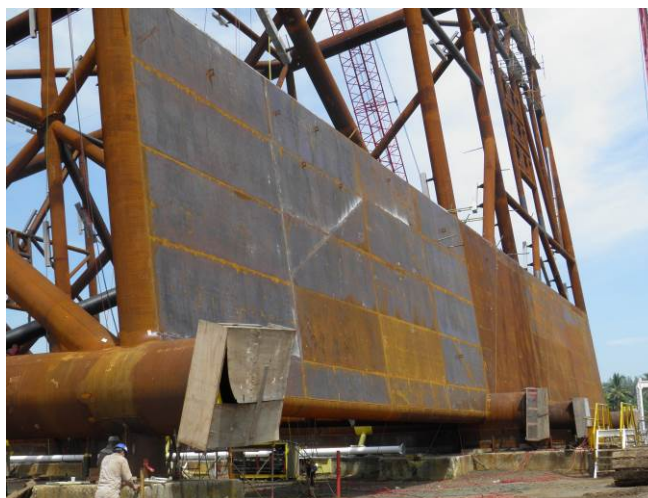
Figura 2.18. Placa base de una subestructura.
