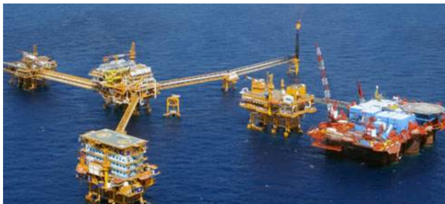
Figura 2.28. Complejo de plataformas marinas. (Ku-Maloob-Zaap).
