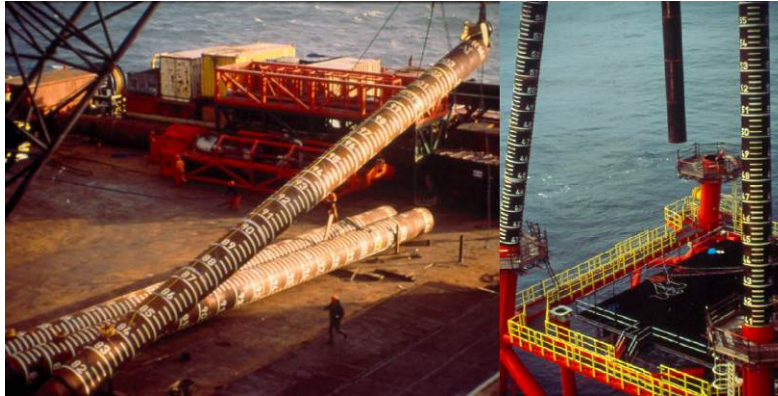
Figura 2.4. Cimentación. Pilotes.
