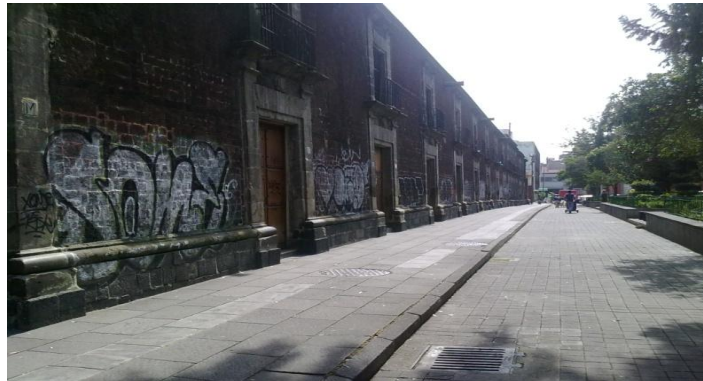
9. Condiciones actuales del edificio
