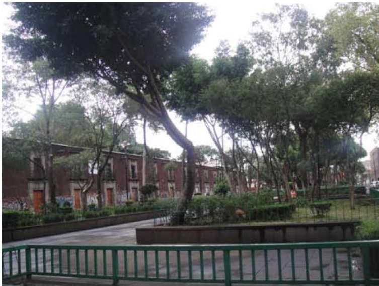
13. Estado actual de la Plaza
