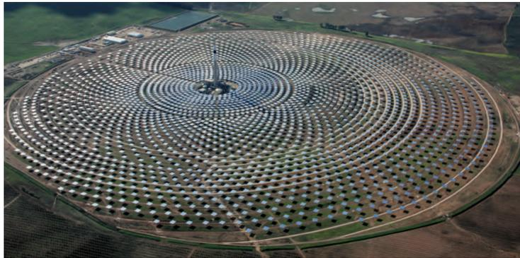
**Figura 1.8** Planta de torre central Gemasolar de 20MW de capacidad nominal y 15 h de almacenamiento, Sevilla, España. Fuente: IDEEA, 2011.
