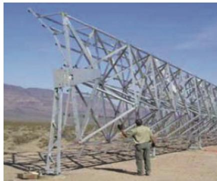
**Figura 2.2** Estructura Space-Frame del colector Solargenix SGX-2Fuente: CSP Today, 2011
