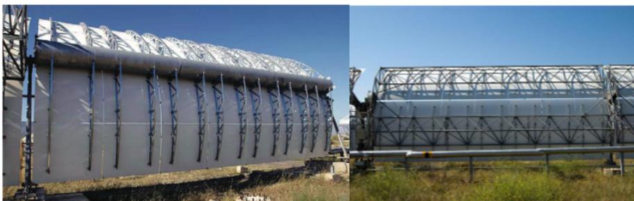
**Figura 2.3** Estructura Tube –Torque y Space-Frame de los colectores Luz LS-2 y LS-3 Respectivamente. Fuente: CSP Today 2011 y Fernández-García et al. 2010
