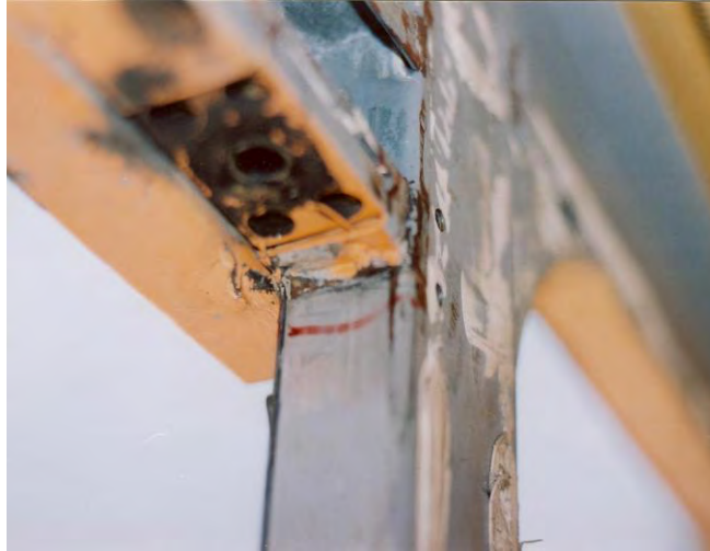
Figura 1.3. Grieta en el marco de la puerta delantera.
