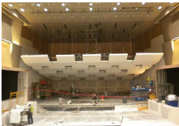
Fotografía 12: Plafón modular y ajustable en altura que permite regular las ondas sonoras dentro del teatro.
