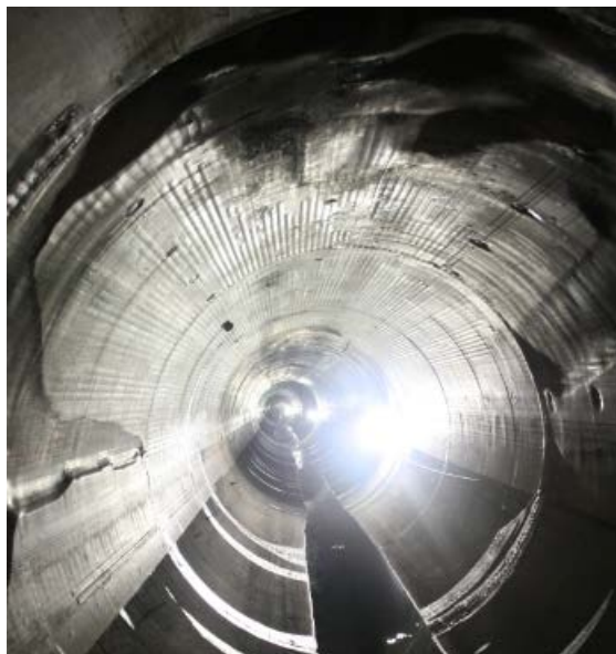
Fotografía 3: Interior del Colector del drenaje profundo que es alimentado por el Colector Río Churubusco. (Sharenii Guzmán /El Universal)
