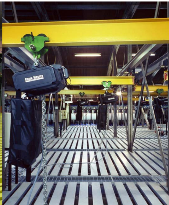
Fotografía 10: Parrilla de tramoya libre de cables. Permite el libre paso para montar escenografías y dar mantenimiento
