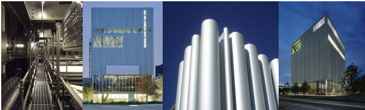
Fotografías 20, 21, 22 y 23: Paso de gato en tramoya, fachada exterior, detalle de fachada de tubulares de aluminio perspectiva desde el exterior.
