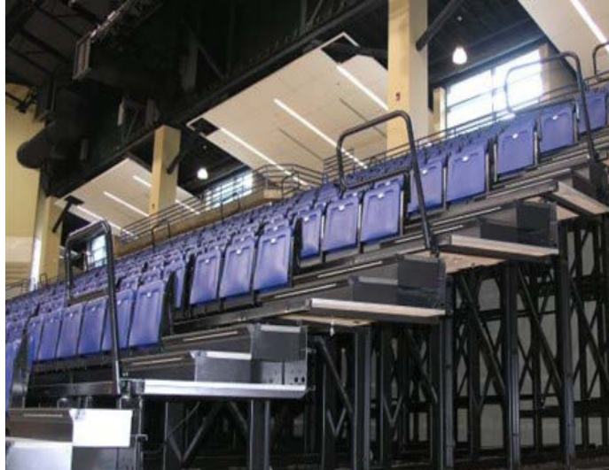
Fotografía 8: Gradas plegables que permiten ser alojadas en un espacio considerablemente reducido y pueden ser reubicadas gracias a que cuentan con ruedas bloqueables.
