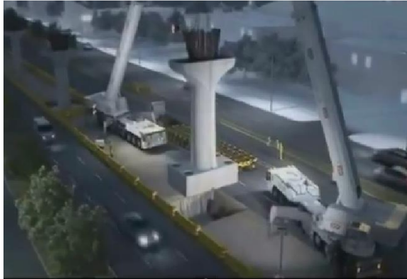
Figura 27. Montaje de zapata-columna
