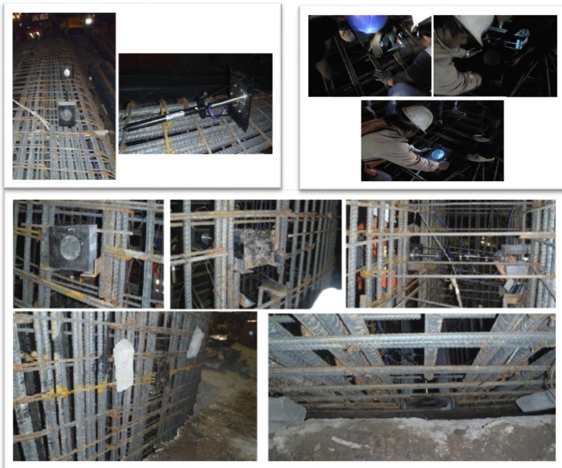
Figura 46. Instalación de celda de presión tipo Jack-Out
