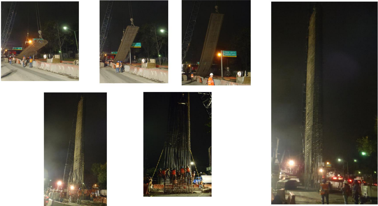
Figura 19. Izaje de la segunda parte del armado y conexión entre ellos
