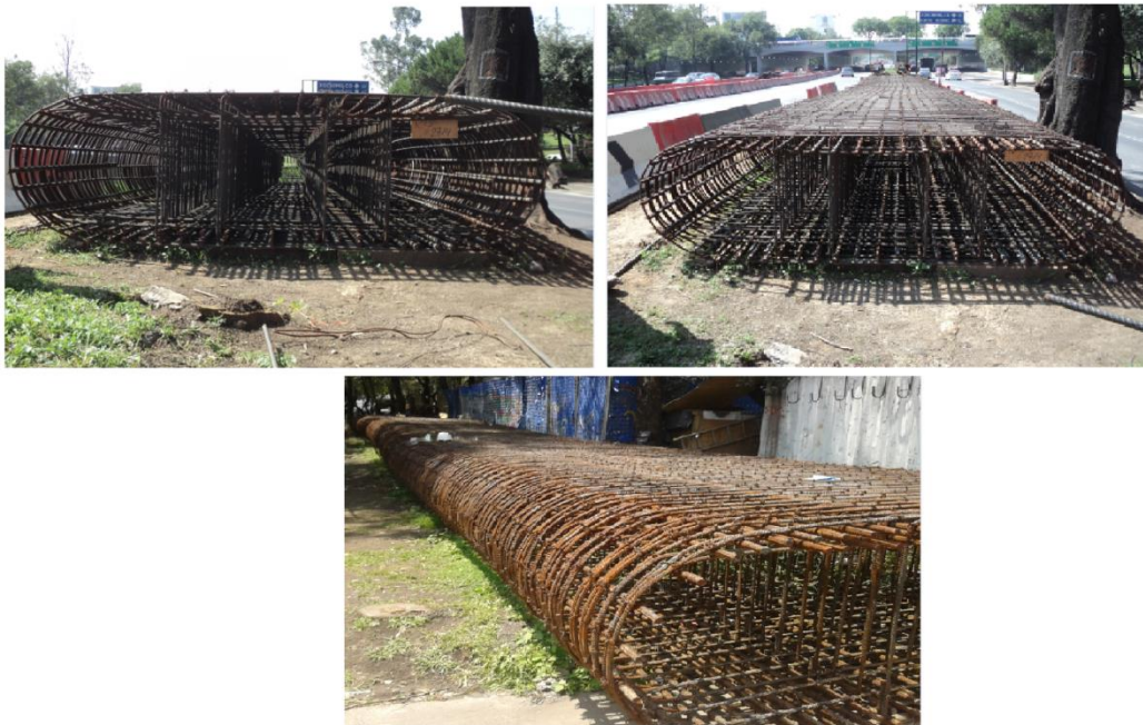
Figura 17. Armado de acero de una pila
