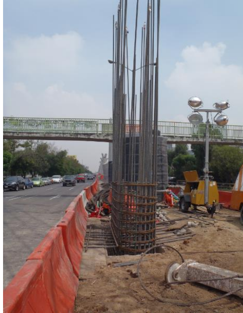
Figura 18. Armado de las pilas dentro de la perforación
