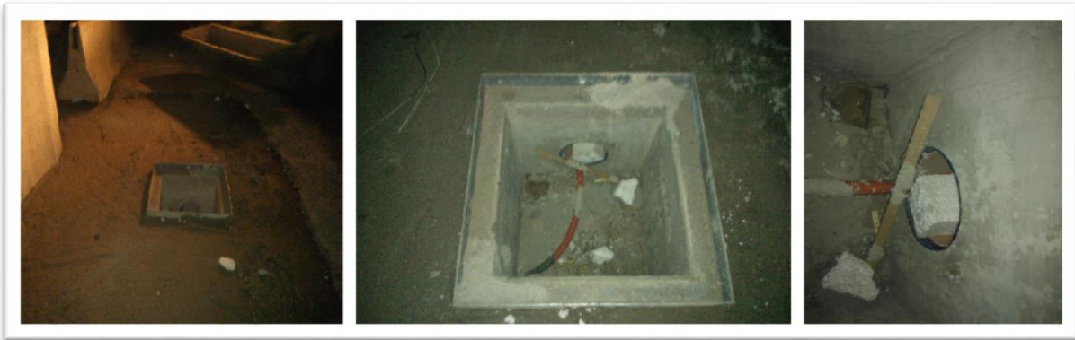
Figura 47. Espacio para instalación de acelerómetros
