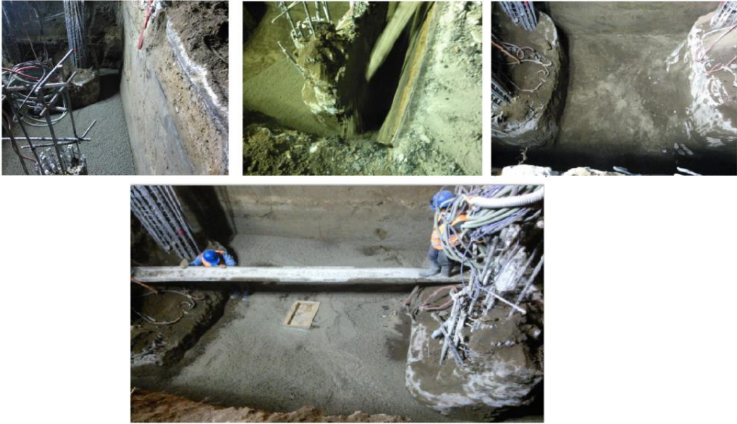
Figura 24. Colado de mejoramiento en concreto
