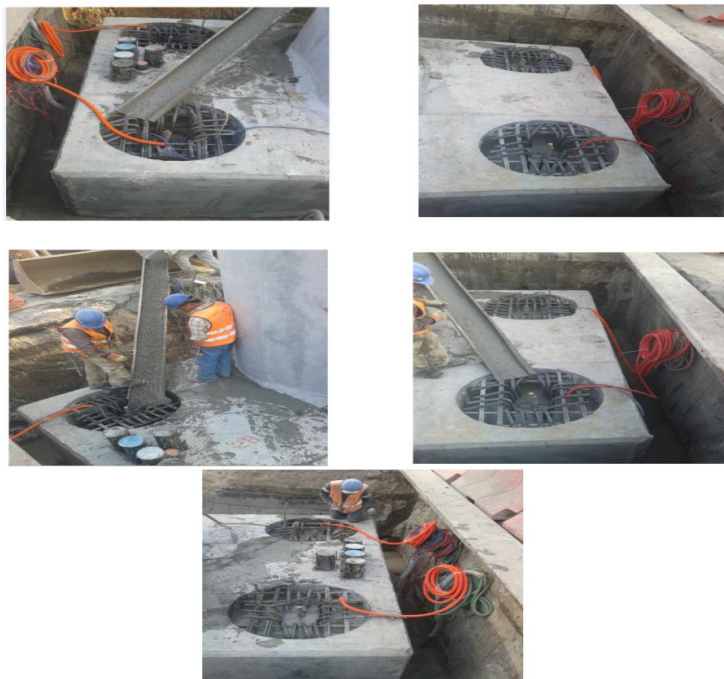
Figura 28. Zapata instalada y colado de conexiones
