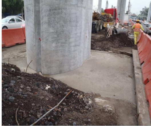
Figura 29. Relleno sobre y a los lados de la zapata
