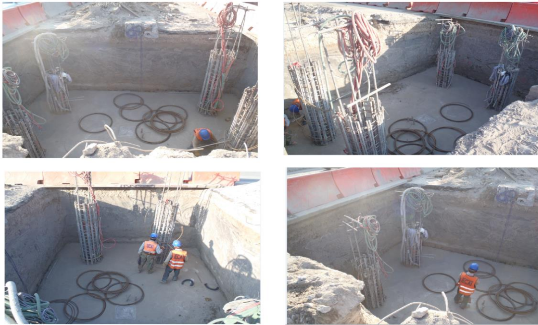
Figura 26. Nivel de desplante de zapata luego de colada la plantilla
