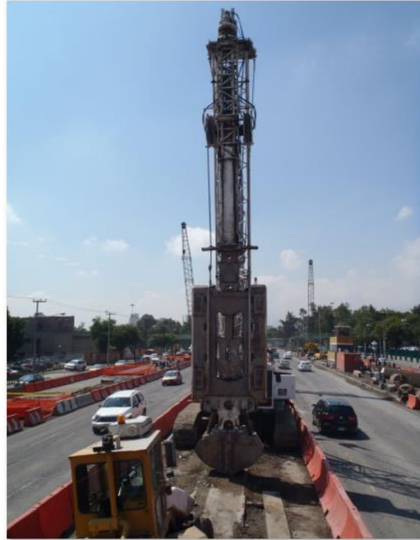
Figura 14. Almeja usada para excavaciones
