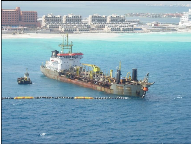
Figura VI.2. Vista de la ejecución de los trabajos de alimentación artificial de arena en la playa de Cancún (año 2006, draga Barent Zanen de la compañía Royal Boskalis Westminster)
