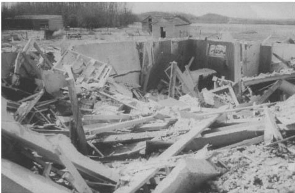
Figura 10. Secuelas de una explosión por gas natural
