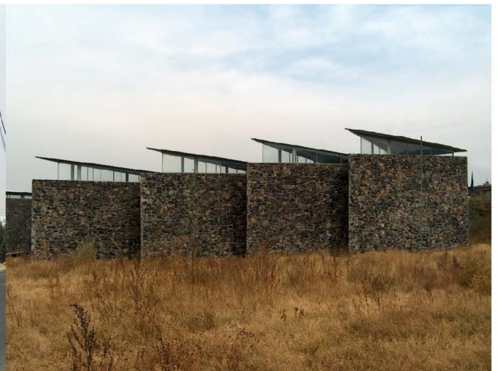
Foto—Campamento de Edificios Públicos. Posterior
