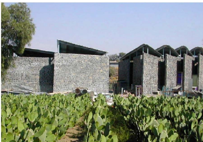
Foto—Campamento de Edificios Públicos. Posterior
