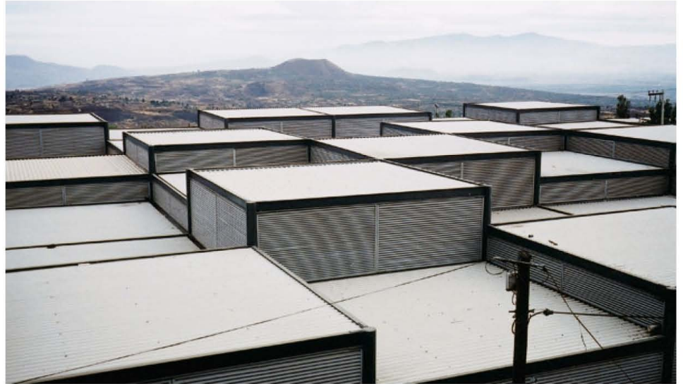
Foto—Mercado de San Pablo Oztotepec. Cubiertas
