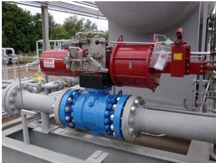
**Figura 24. Válvula de Corte (SDV).**
