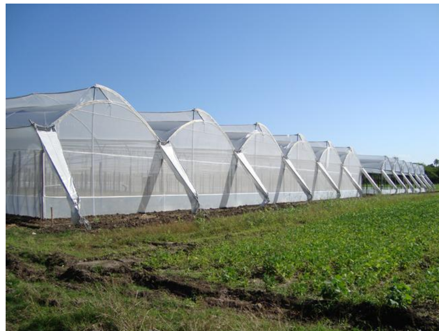
Fig. 34 Invernadero con ventilación natural.
