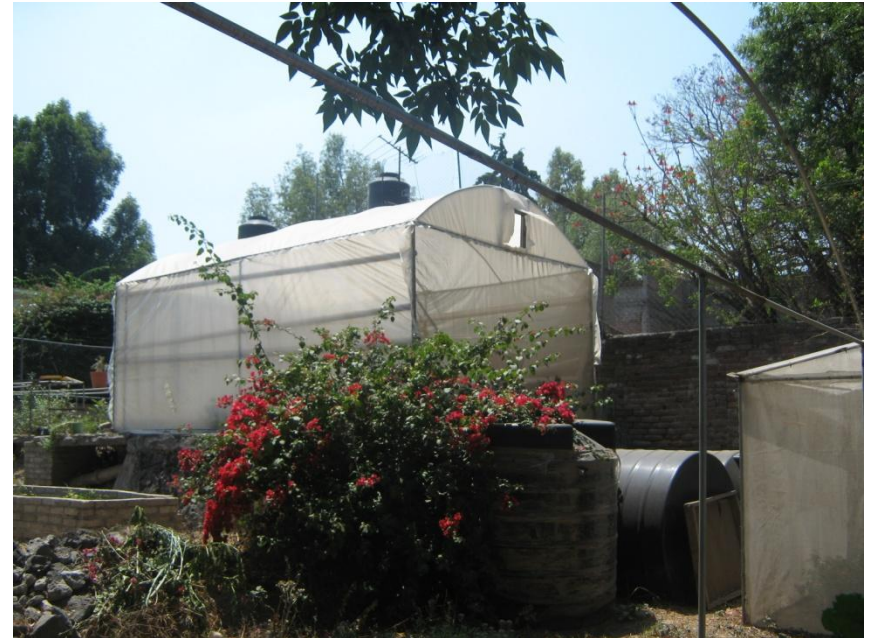
Fig. 21 Vista del invernadero, se captara el agua de lluvia y se almacenara en estos tinacos.
