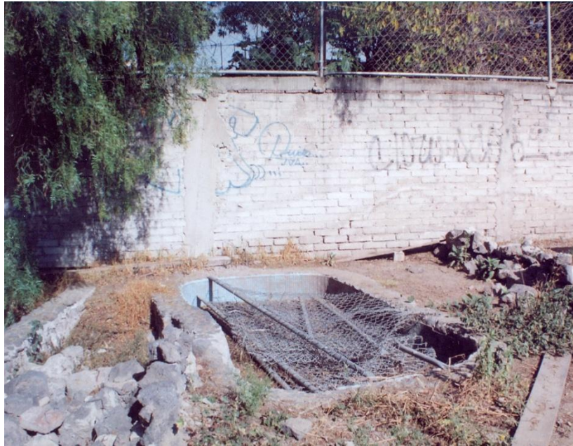
Fig. 25 Conserva una tina, esta se aprovechara para un estanque. Se adaptara para la cría de ranas.
