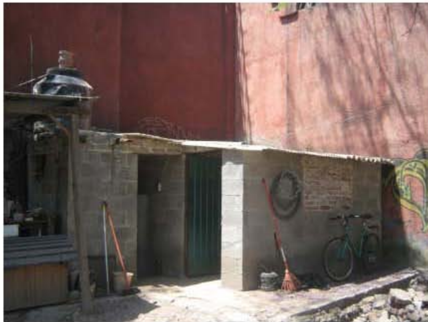
Fig. 18 Vista del acceso del laboratorio.
