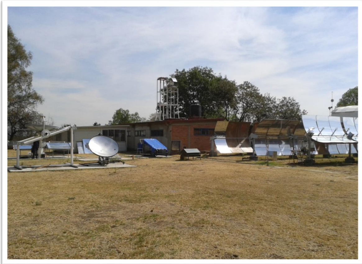
Figura 5. Vista de la Planta Solar del Instituto de Ingeniería de la UNAM.
