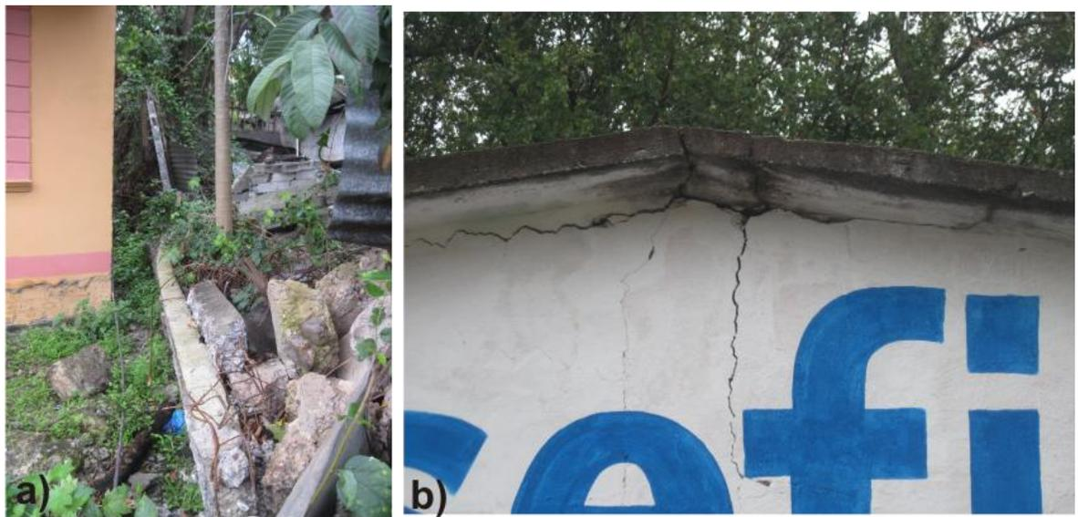
*Figura 3. 16. a) Se muestra el daño de una barda causado por el deslizamiento en masa del suelo sobre el cual está construida b) Daños a una construcción también ocasionados por el deslizamiento del suelo, esta reptación se debe a un horizonte saturado en agua.*
