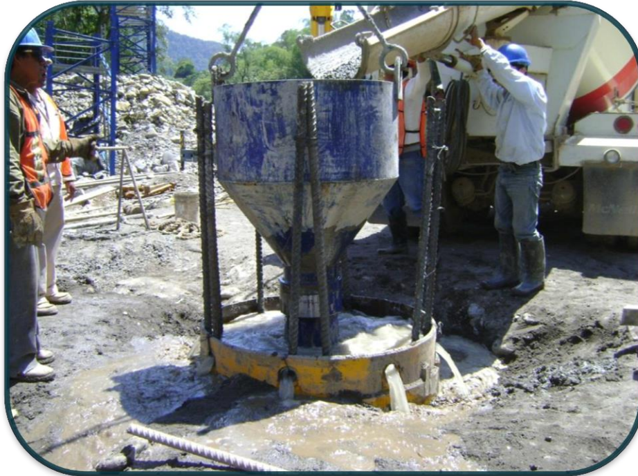
FOTOGRAFIA No.29.-El concreto va subiendo y desplaza toda las impurezas que aparezcan a lo largo del pilote.
