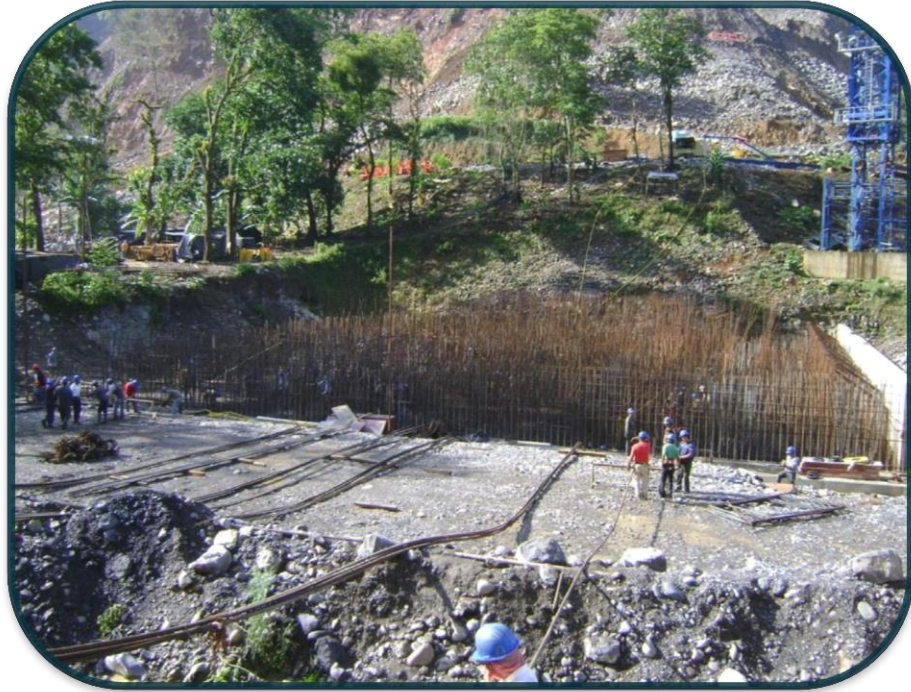
FOTOGRAFIA No.55.-Las cantidades de acero por día superaron la tonelada de acero por obrero.
