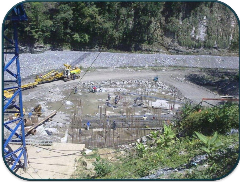
FOTOGRAFIA No.21.-Se necesito una coordinación metódica para la fabricación de los pilotes conforme se iban perforando.
