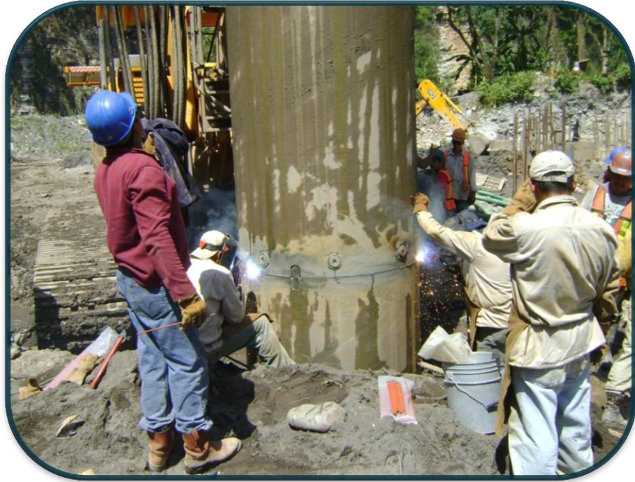
FOTOGRAFIA No.19.-Para evitar esas filtraciones se soldaron todas las uniones posibles.
