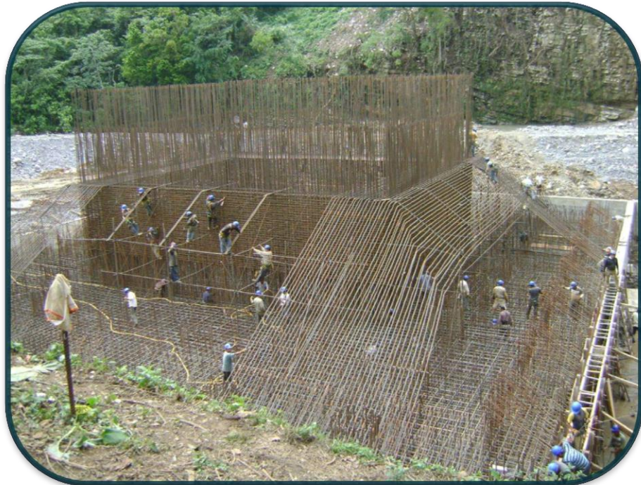
FOTOGRAFIA No.54.-Se realizaron dos equipos de trabajo, uno para cada turno.
