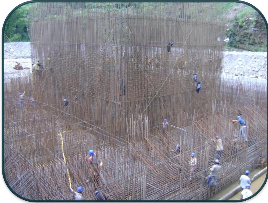
FOTOGRAFIA No.63.-El personal comprometido y el entendimiento de la importancia de esta zapata contribuyo a la eficiencia.
