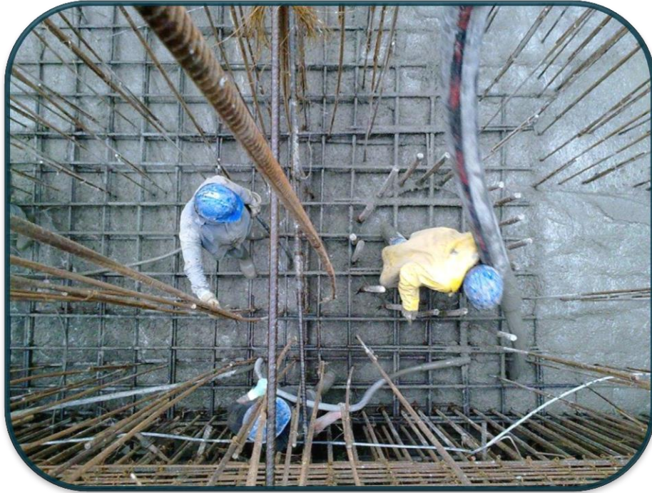
FOTOGRAFIA No.83.-En algunas partes de la zapata el volumen de acero permitía la maniobrabilidad de los equipos lo cual facilitaba muchas labores en el colado.
