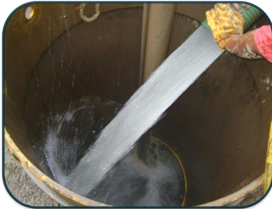
FOTOGRAFIA No.14.-El agua que se introduce al pilote es limpia.
