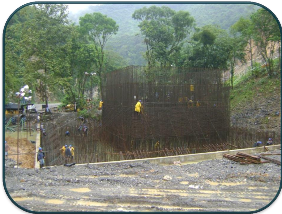
FOTOGRAFIA No.60.-A pesar de que solo se colara la zapata se tenia que colocar las varillas que se desplantan desde esta por lo cual complico la maniobra.
