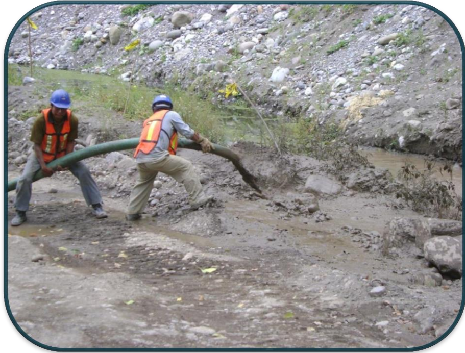
FOTOGRAFIA No.15.-El resultado de la extracción de agua es una mezcla de lodo a principio.
