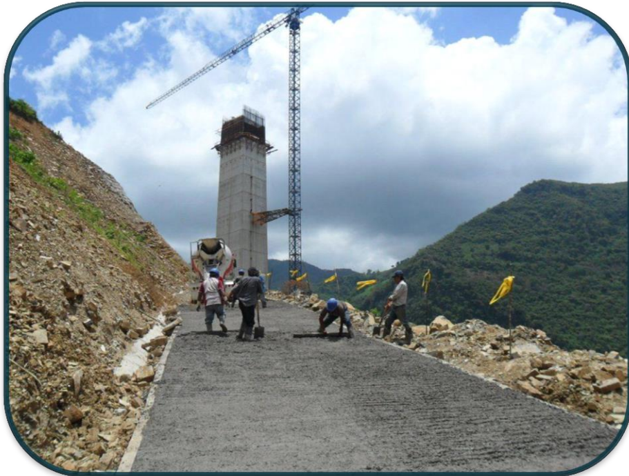
FOTOGRAFIA No.10.-Los colados de los caminos se realizaban los sábados para no estorbar a otros frentes que ocupaban estos accesos, o en algunas ocasiones en la semana por las tardes.
