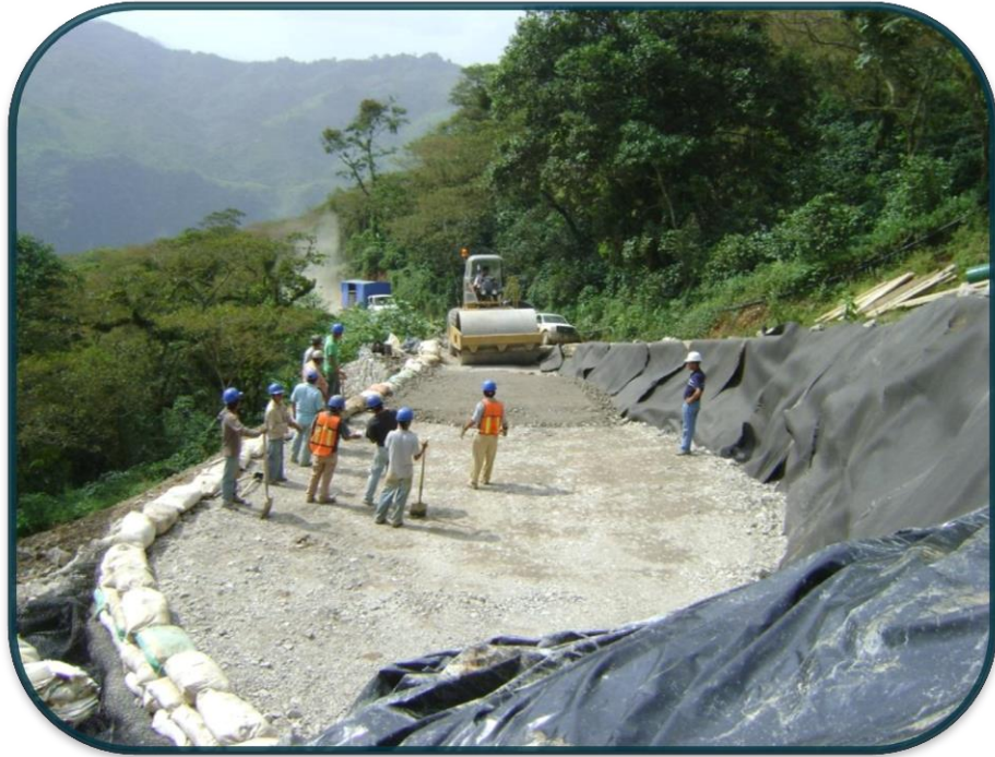
FOTOGRAFIA No.9.-Como ya se menciona se realizaron trabajos de mejoramiento de caminos y ampliaciones de curvas para la facilitación del acceso a los equipos de trabajo.
