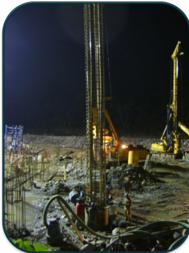
FOTOGRAFIA No.24.-En algunos izajes se utilizaron dos grúas para evitar que con el peso del acero se doblara el pilote cuando este se coloca en su ademe.
