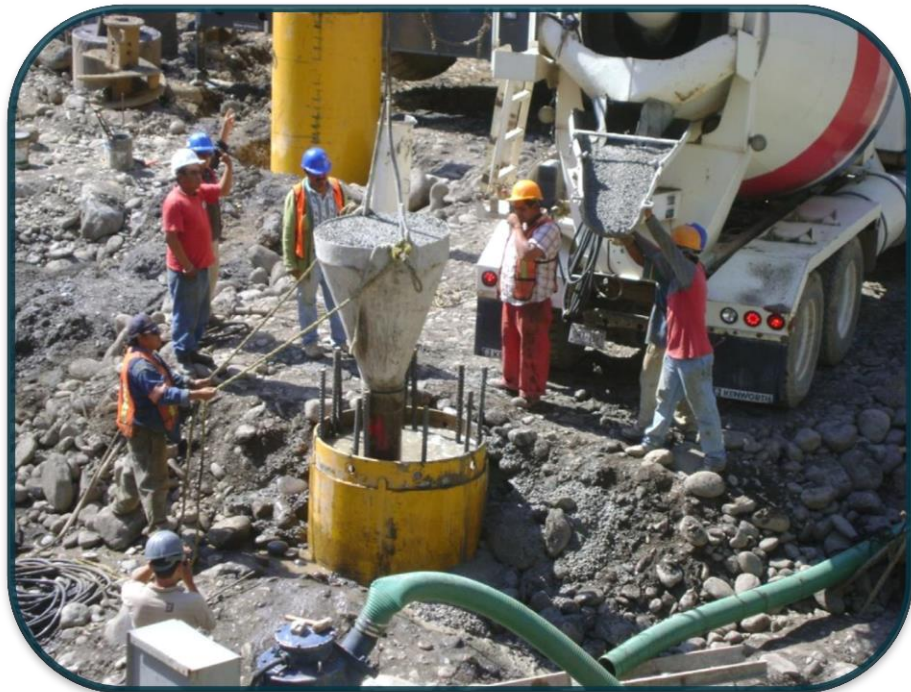
FOTOGRAFIA No.26.-El proceso es sencillo conforme se llena se realiza un movimiento ascendente y descendente controlado que permite que no se contamine el concreto con las partículas sobrantes y el agua existente.
