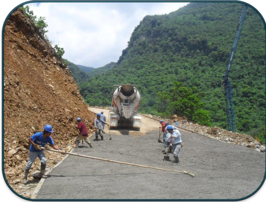
FOTOGRAFIA No.11.-Principalmente se ampliaron las curvas de los accesos y las pendientes mas críticas.
