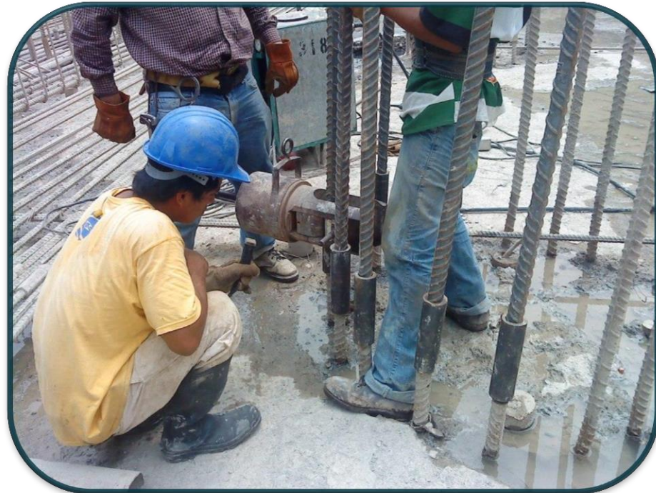
FOTOGRAFIA No.50.-En este proyecto se utilizaron coples de rosca y de compresión para este caso por su comodidad se utilizo el de compresión por medio hidráulico.
