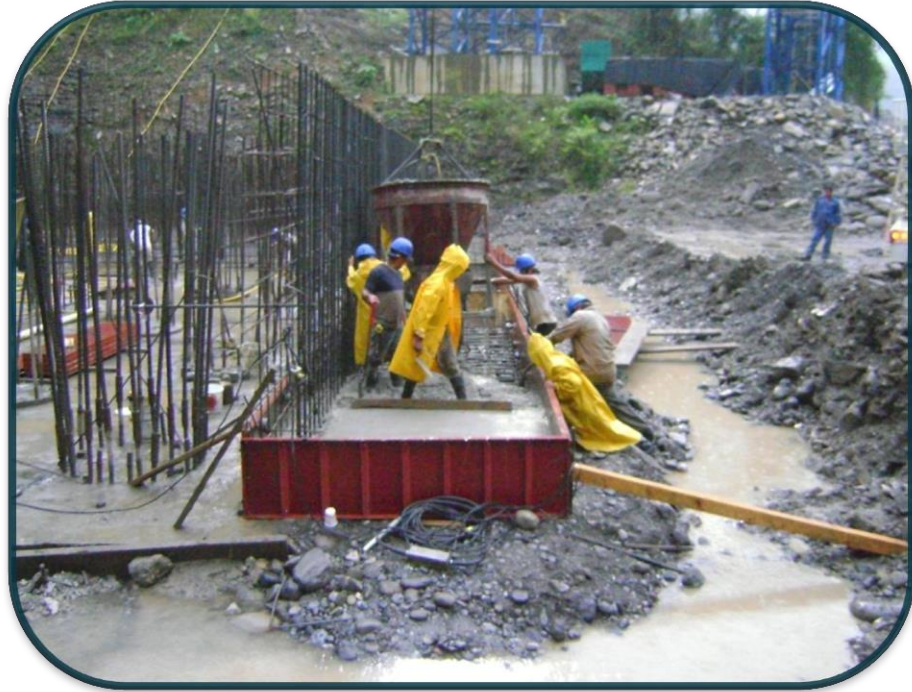
FOTOGRAFIA No.47.-Algunos de los colados se realizaron a pesar de las lluvias que se presentaron.
