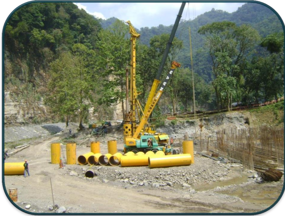
FOTOGRAFIA No.5.-Para estos pilotes se utilizo un ademe de acero de 0.5" de espesor que se armaba conforme se perforaba.
