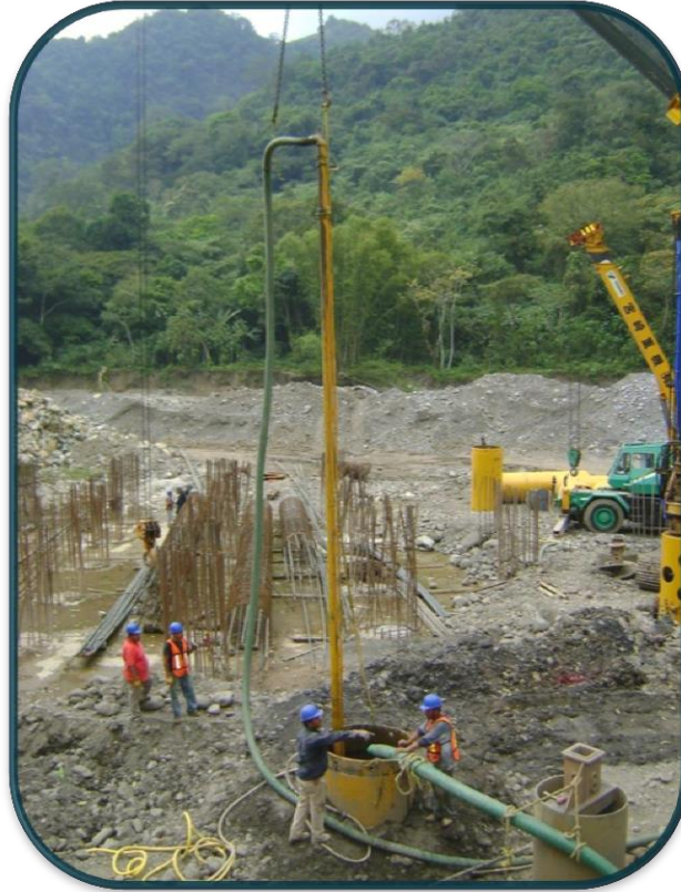
FOTOGRAFIA No.17.-Algunas veces se diseñaron tuberías a presión con aire para limpieza de arenas existentes
