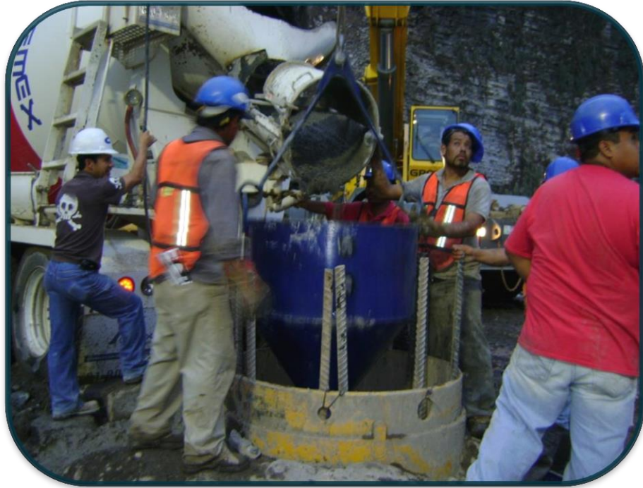
FOTOGRAFIA No.25.-El tubo tremi tiene uniones y un embudo con el cual se puede colocar el concreto mas fácilmente.
