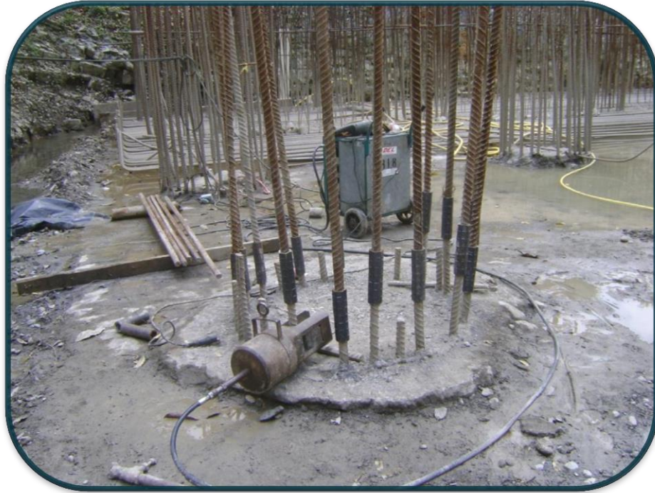
FOTOGRAFIA No.49.-A los pilotes se les acoplaron varillas por medio de un cople de compresión.
