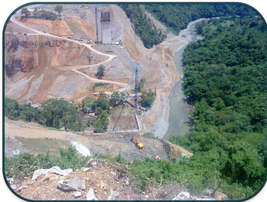
FOTOGRAFIA No.7.- Previo a la excavación se le da trazo topográfico de cada centro de pilote y se verifica su verticalidad constantemente además de que se construye una plataforma de trabajo a la perforadora de 1 m de espesor.
