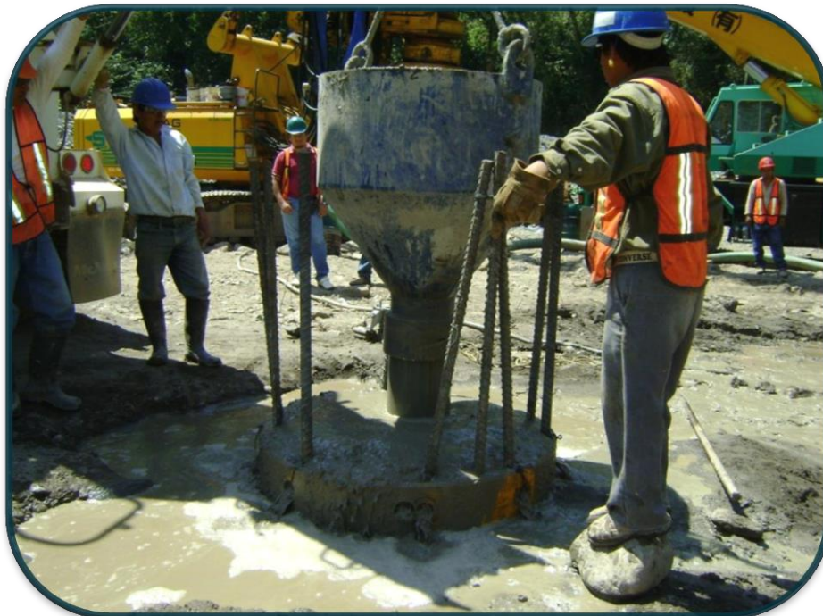
FOTOGRAFIA No.30.-Se puede ver a simple vista como sale de contaminado el concreto y como baja la calidad de este al principio.
