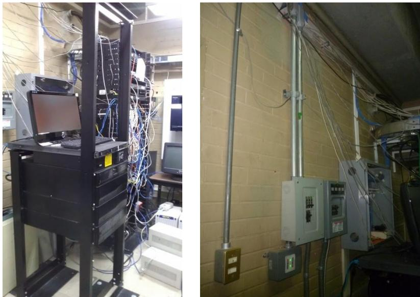
**Figura 3.4.** Sistema de alimentación ininterrumpida (UPS) y tableros eléctricos.
