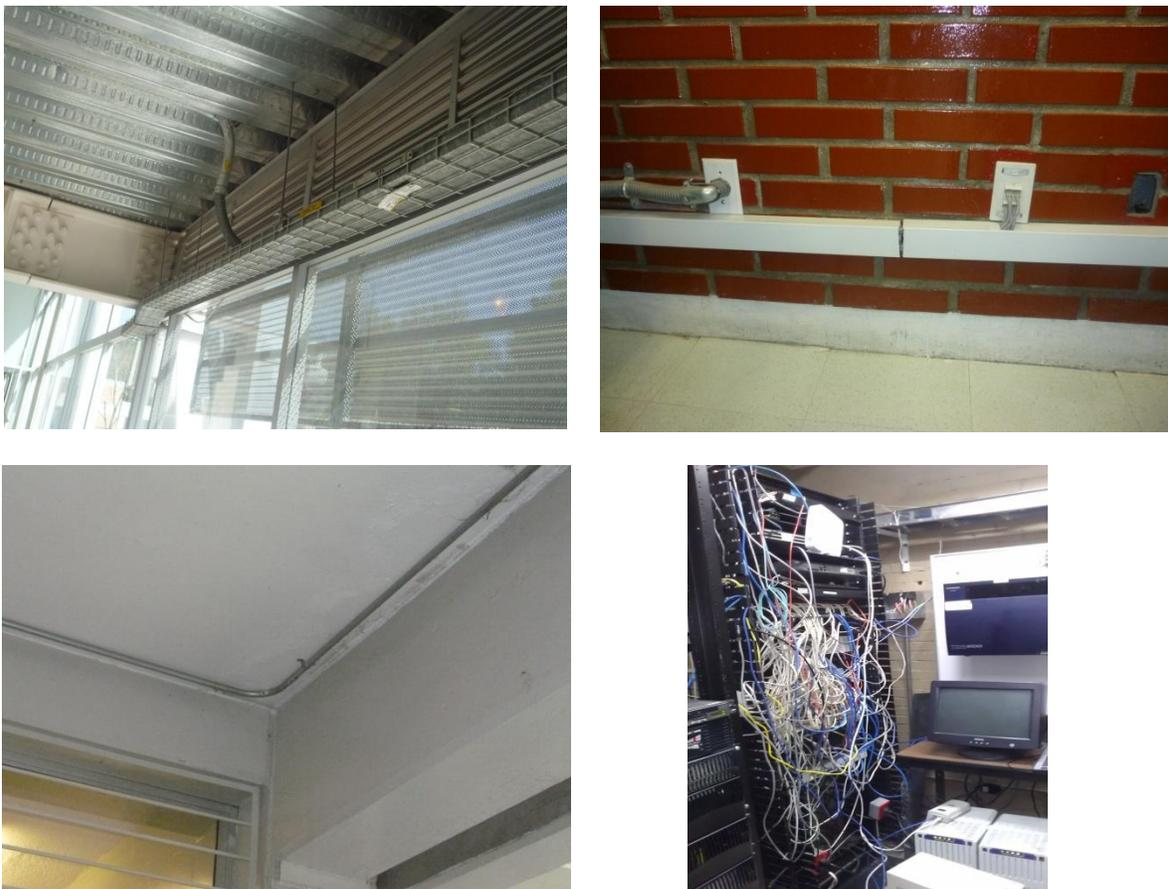
*Figura 3.16. Cableado Horizontal canalizaciones.*
