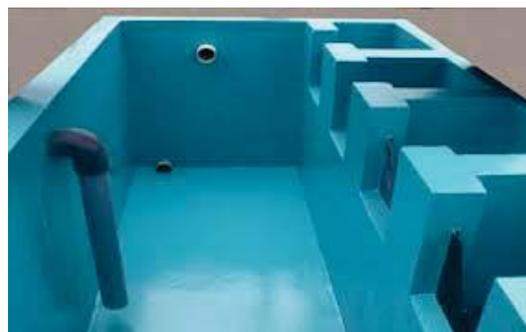
Del grupo de cisternas ubicadas en la planta de estacionamiento del conjunto de torres se distribuyen ramales que bombean el agua con ayuda de equipos hidroneumáticos. Dentro del conjunto de edificios de manera independiente existirán dos ramales, una de ellas será exclusivamente para el uso de la red contra incendios y otra para el uso normal de servicios sanitarios, así mismo cada servicio contara con llaves de paso independientes para su fácil mantenimiento.
