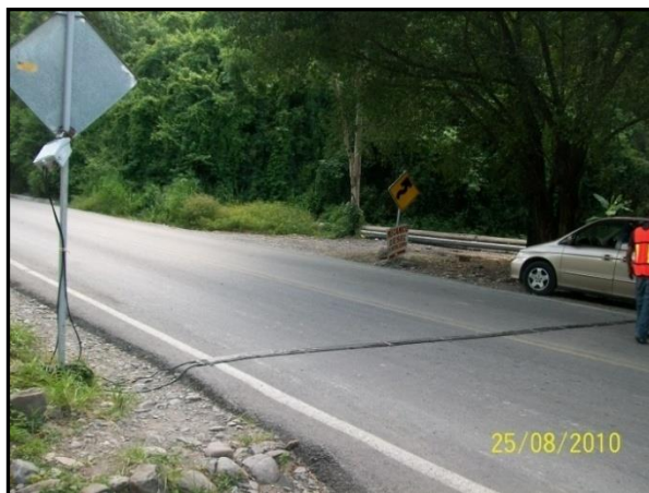
Figura 42 Imágenes de los contadores automáticos en carretera.
