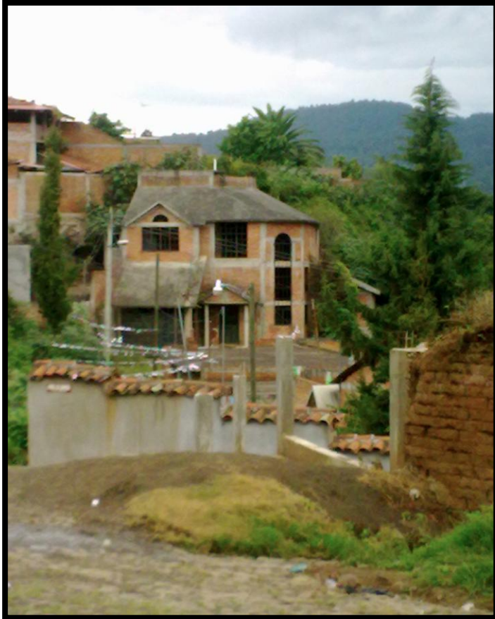
Fotografía 15. Contraste de materiales y fachada de casa-habitación [Archivo personal. Miriam rt. Febrero 2012]
