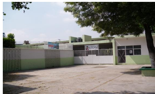
Foto 2. Vista del frente de la escuela
