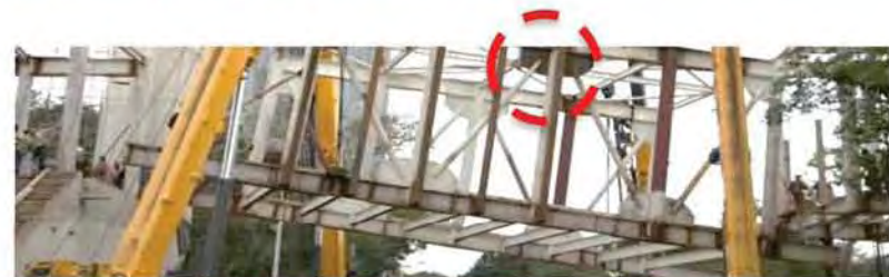
Gráfico 81. Perfiles tubulares circulares que rematan en nodos de placa de acero en las intersecciones de la armadura portante. Fotógrafo: Luis Gordo. 2011.
