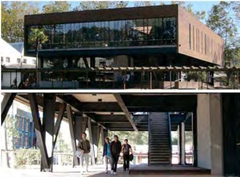
Gráfico 87. Acceso principal al conjunto, por medio de una planta libre. fuente: Rubén Muñoz Arquitecto, 2008.
