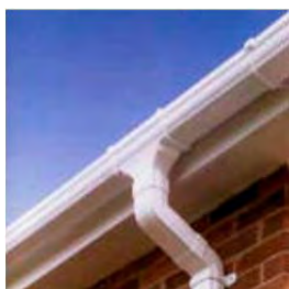
Fotografía 6 Canaletas de recolección
