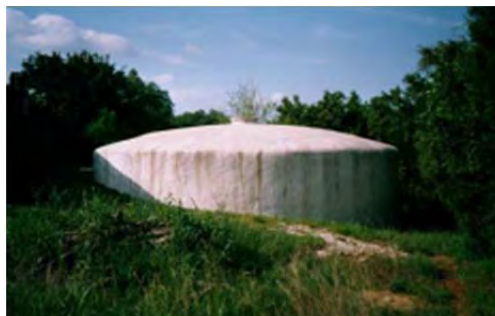
Fotografía 5. Tanque de almacenamiento semienterrado en ferro-cemento.
