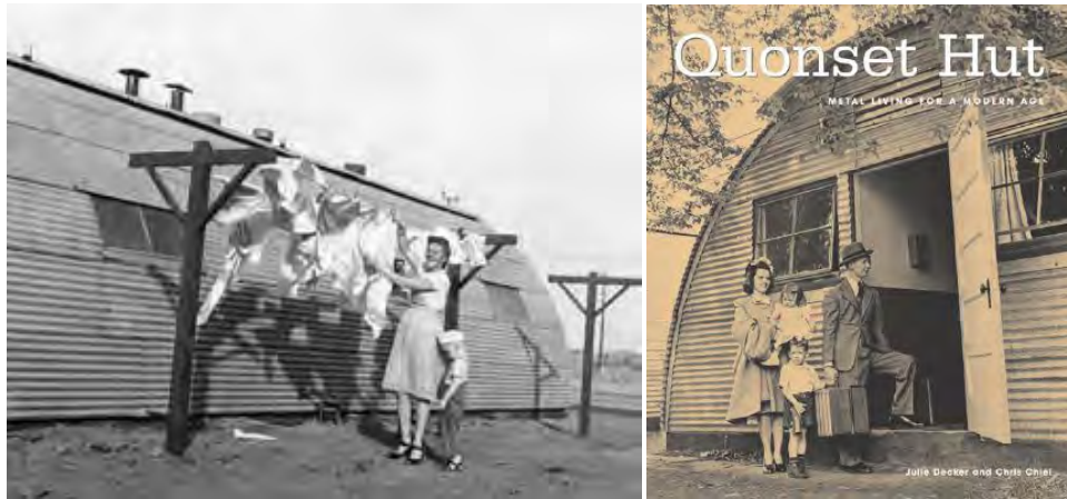
Fig. 3 Albergues “Quonset hut”, diseñados en época de guerras, www.steelmasterestructuras.com
