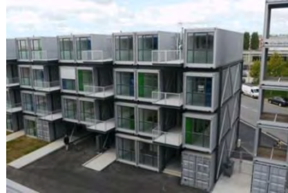
Fig. 21 Contenedor de 20 pies como módulo de vivienda.
