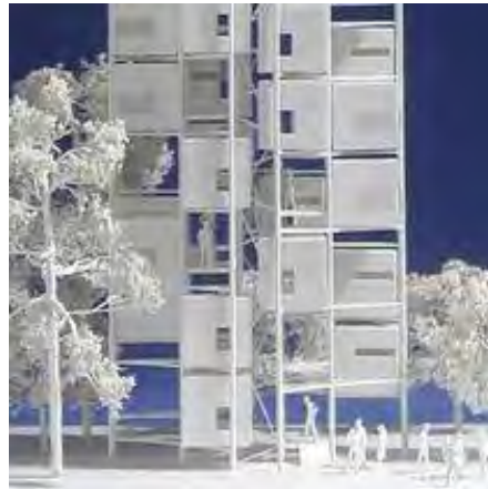
Fig. 20 Edificio de viviendas con estructura portante independiente para alojar módulos, http://www.archiexpo.es/prod/micro-compact-home/edificios-modulares-prefabricados-contemporaneos-ecologicos-para-viviendas-colectivas-70395-521598.html
